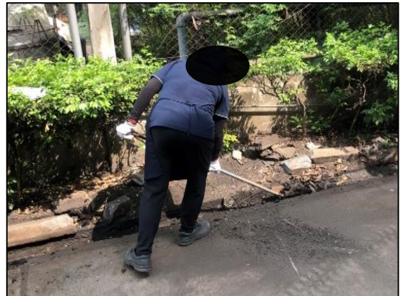
รูปที่ 18 การขุดลอกทรายระบายน้ำ
