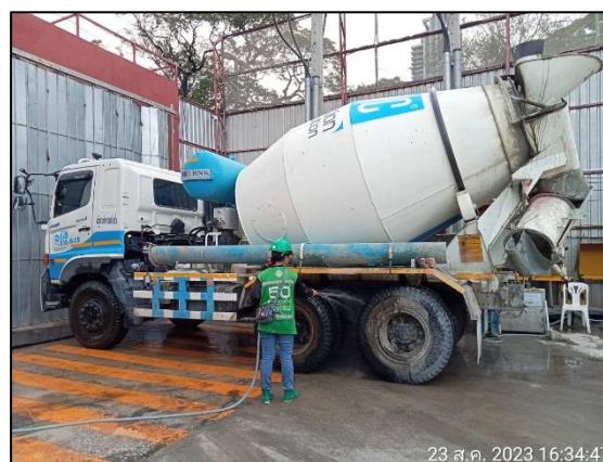
รูปที่ 2-8 กิจกรรมทำความสะอาดล้อรถบรรทุกก่อนออกนอกบริเวณโครงการ
