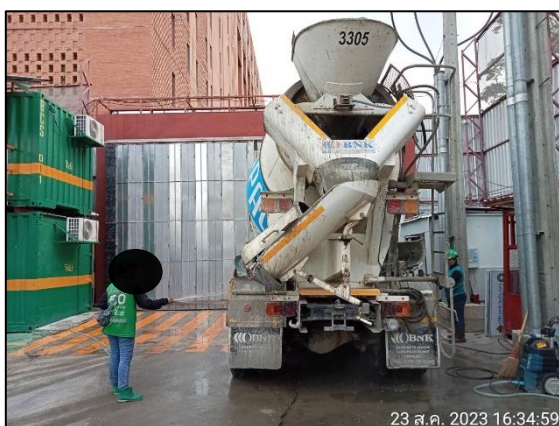
รูปที่ 2-8 กิจกรรมทำความสะอาดล้อรถบรรทุกก่อนออกนอกบริเวณโครงการ
