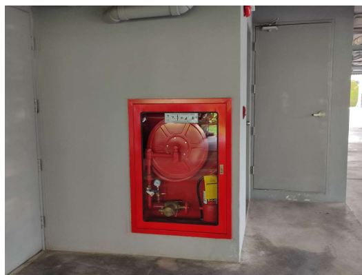
ภาพที่ 4-29 ระบบท่อเย็นพร้อมตู้เก็บอุปกรณ์ดับเพลิง
