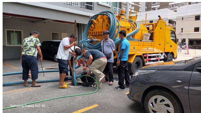
ภาพที่ 4-33 ดูดตะกอนบ่อเกรอะ
