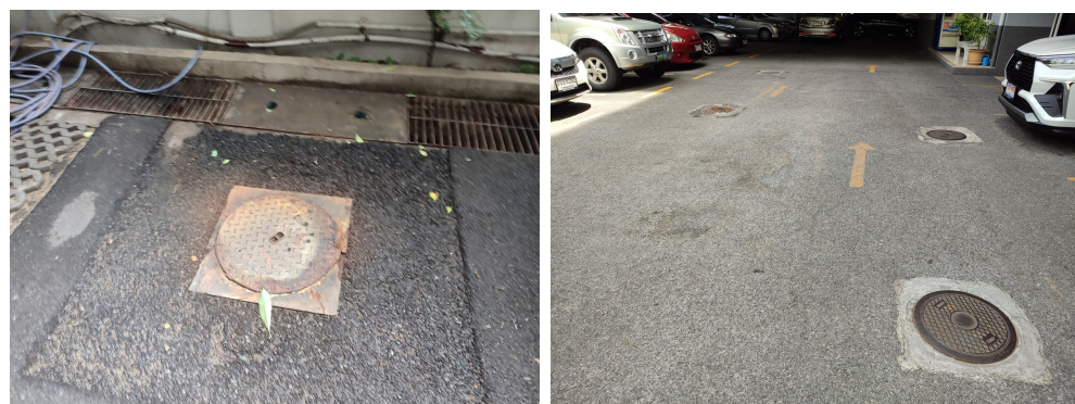
ภาพที่ 4-5 ฝาถังตกตะกอนและบ่อพักน้ำทิ้งก่อนปล่อยออกสู่ท่อระบายสาธารณะ
