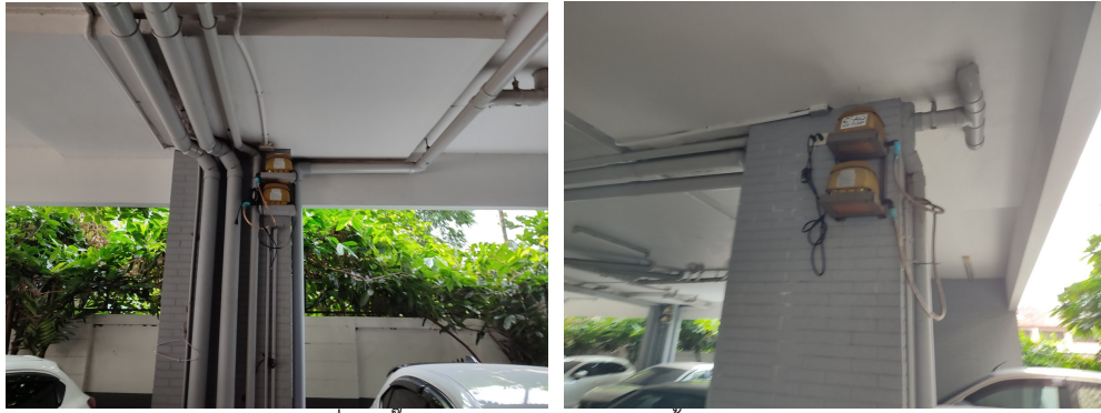
ภาพที่ 4-3 บั้มเติมอากาศในระบบบำบัดน้ำเสียแต่ละส่วน
