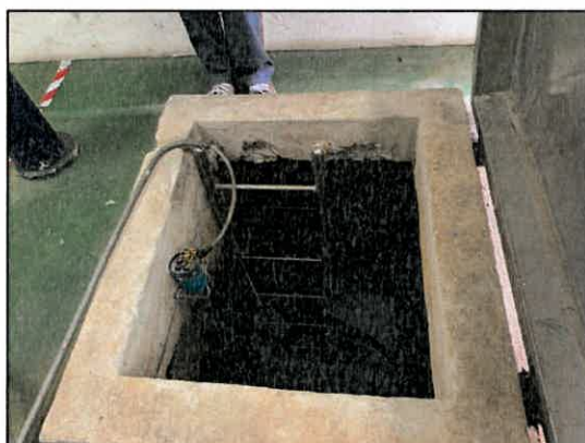
รูปที่ 3-5 ถังเก็บน้ำใต้ดิน
