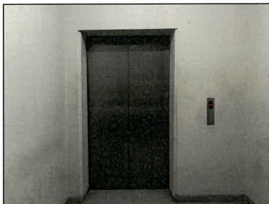
รูปที่ 3-24 ลิฟต์ดับเพลิง
