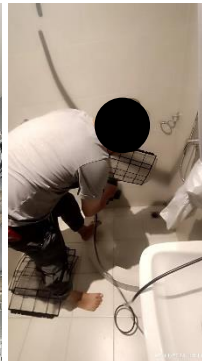
รูปที่ 3-23 ล้างเครื่องปรับอากาศและล้างฟิลเตอร์พื้นที่ส่วนกลาง
