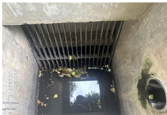
รูปที่ 3-21 ติดตั้งตะแกรงดักขยะ
