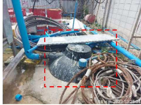
รูปที่ 24 ถังบำบัดน้ำเสียสำเร็จรูป
