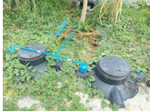
รูปที่ 36 ถังบำบัดน้ำเสียสำเร็จรูป บ้านพักคนงาน
