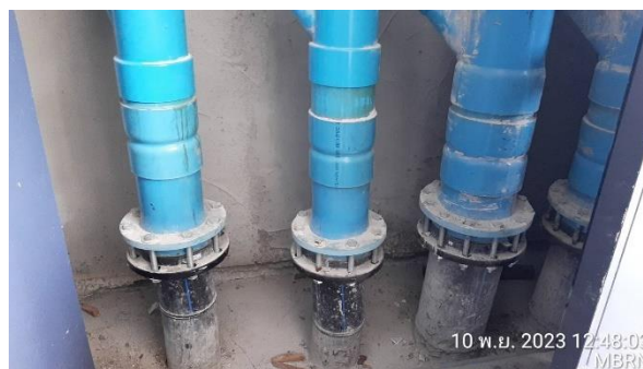
รูปที่ 24 ท่อรวบรวมน้ำห้องพักมูลฝอยเข้าสู่ระบบบำบัดน้ำเสียของโครงการ
