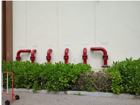
ภาพที่ 3-23 หัวรับน้ำดับเพลิงจากภายนอกของโครงการ
