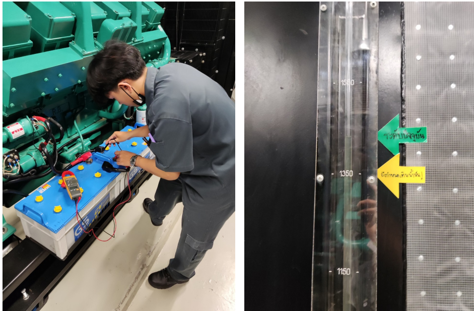
ภาพที่ 3-47 ดูแลรักษา และทดสอบเครื่องไฟฟ้าฉุกเฉินทุกสัปดาห์
