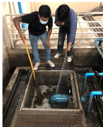
ภาพที่ 3-8 สูบน้ำกากไขมันออกจากบ่อดักไขมัน และดูแลรักษาระบบบำบัดน้ำเสีย
