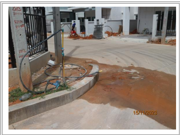
รูปที่ 3-3 พื้นที่ล้างล้อรถก่อนออกนอกโครงการ
