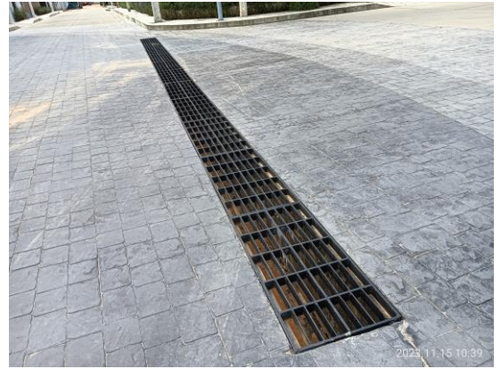
รูปที่ 3-7 รางระบายน้ำรอบพื้นที่โครงการ
