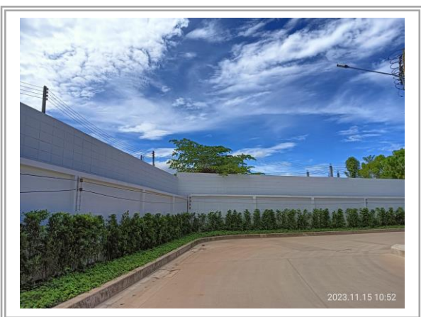
รูปที่ 3-5 รั้วรอบพื้นที่โครงการ ความสูง 3 เมตร
