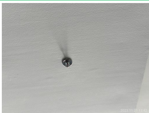
รูปที่ 3.2-32 ระบบหัวกระจายน้ำดับเพลิงอัตโนมัติ (Sprinkler System)
