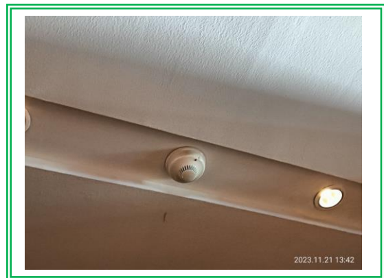
รูปที่ 3.2-35 เครื่องตรวจจับควัน (Smoke Detector)
