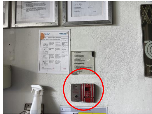
สวิตช์กดแจ้งเหตุด้วยมือ (Fire Alarm Manual Station)
