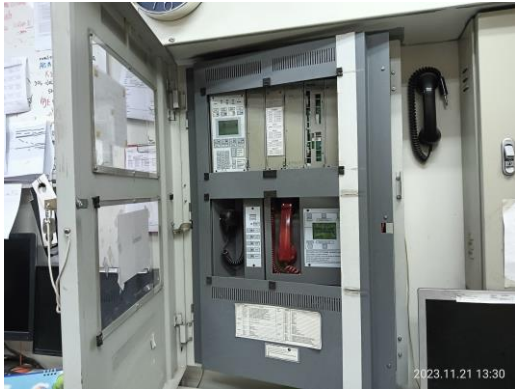
แผงควบคุม (Fire Alarm Control Panel: FACP)
