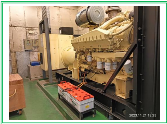
เครื่องกำเนิดไฟฟ้าฉุกเฉิน ส่วนศูนย์การค้าและสำนักงาน
