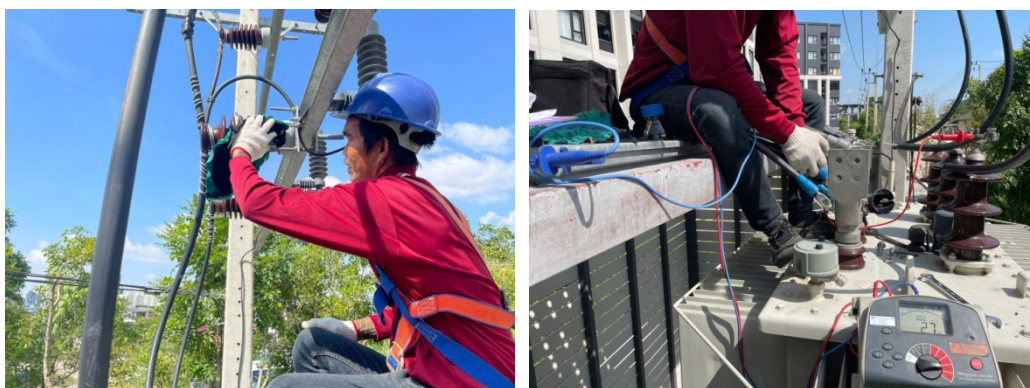
ภาพที่ 3-30 ตรวจสอบและซ่อมบำรุง หม้อแปลงไฟฟ้า
