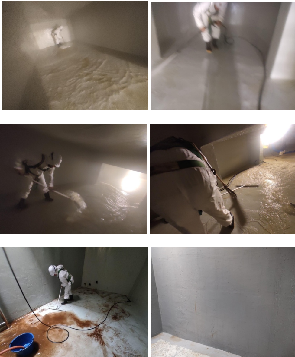
ภาพที่ 3-28 ล้างทำความสะอาดบ่อสำรองน้ำใช้
