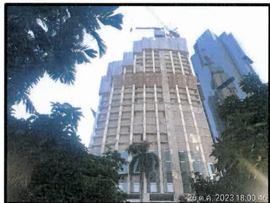
รูปที่ 3-5 ผ้าใบ Mesh sheet ชนิดกันไฟลาม คลุมโดยรอบอาคาร
