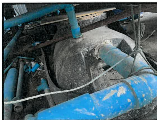
รูปที่ 3-15 ถังบำบัดน้ำเสียในพื้นที่ก่อสร้าง
