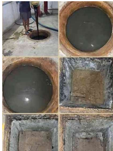
สูบล้างปฏิกูลออกจากบ่อดักไขมัน และเดิมสารชีวภาพในบ่อดักไขมัน ภาพที่ 3-27 ดูตะกอนไขมันและตะกอนในบ่อกักเก็บตะกอนของระบบบำบัดน้ำเสีย
