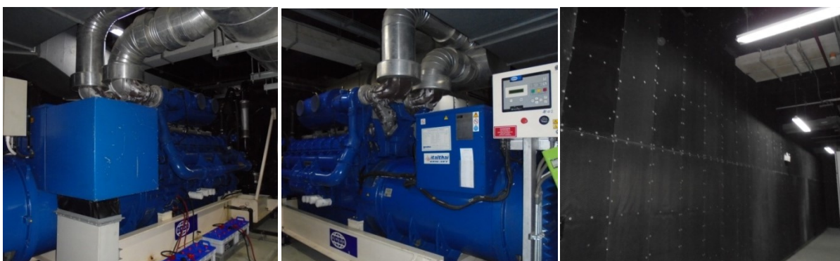
ที่ 3-26 ห้องเครื่องไฟฟ้าฉุกเฉินมีระบบฉนวนป้องกันเสียงดัง ปล่องไอเสีย และเครื่องตรวจจับความร้อน
