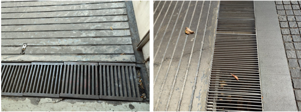
ภาพที่ 3-29 ตรวจสอบสภาพรางระบายน้ำมีสภาพดีไม่มีสิ่งอุดตันการระบายน้ำมีประสิทธิภาพ
