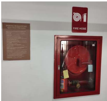
ตู้เก็บสายฉีดน้ำดับเพลิงพร้อมอุปกรณ์ ระบบท่อเย็น และสัญญาณแจ้งเตือนอัคคีภัย
