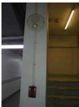
ลิฟต์ดับเพลิง เครื่องส่งสัญญาณโดยใช้มือถือ ภาพที่ 3-14 อุปกรณ์ป้องกันและเตือนอัคคีภัย
