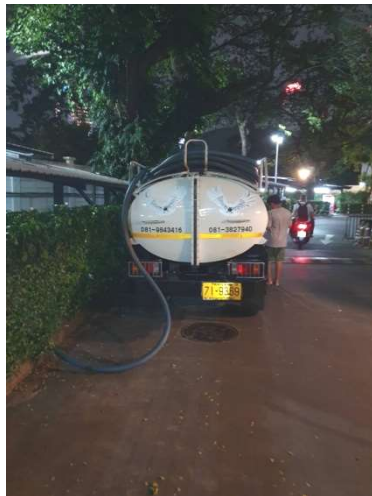
สูบล้างปฏิกูลออกจากบ่อดักไขมัน และเดิมสารชีวภาพในบ่อดักไขมัน ภาพที่ 3-27 ดูตะกอนไขมันและตะกอนในบ่อกักเก็บตะกอนของระบบบำบัดน้ำเสีย
