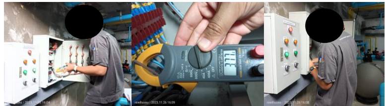
ตรวจสอบและทำความสะอาดปั๊มสระว่ายน้ำ
