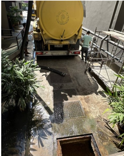
ภาพที่ 5-31 คูตะกอนที่บ่อเก็บตะกอนของระบบบำบัดน้ำเสีย
