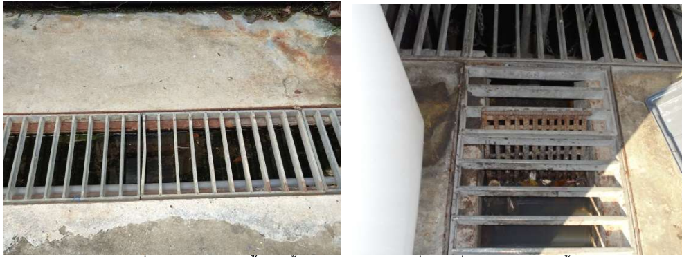
ภาพที่ 3-14 รางระบายน้ำ ติดตั้งตะแกรงดักขยะไว้เพิ่มเติมที่ปลายท่อ บ่อพักน้ำ
