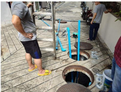
ภาพที่ 3-33 เก็บขยะที่อุดตันรางระบายน้ำ และทำความสะอาดรางระบายน้ำ
