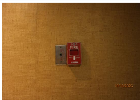
รูปที่ 3-57 สวิตช์แจ้งสัญญาณเพลิงไหม้อาคาร
