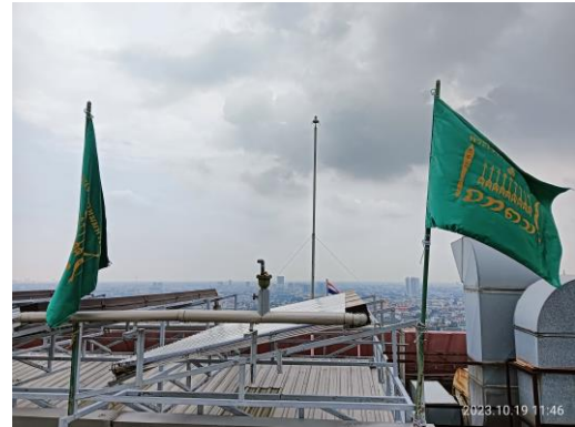
รูปที่ 3-37 ตัวนำล่อฟ้าของอาคาร
