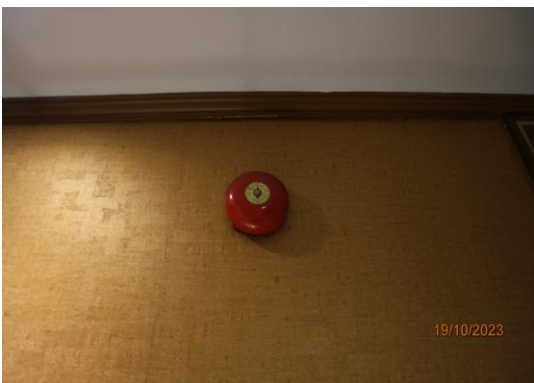
รูปที่ 3-56 อุปกรณ์ส่งเสียงสัญญาณเตือนภัย
