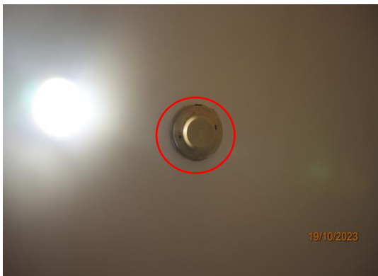
รูปที่ 3-54 เครื่องตรวจจับความร้อน
