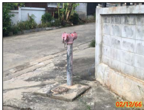
รูปที่ 2.2-2 หัวรับน้ำดับเพลิงภายในโครงการ
