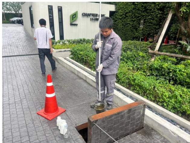
บ่อพักน้ำสุดท้ายของระบบระบายน้ำของโครงการก่อนระบายออกสู่ระบบระบายน้ำบริเวณด้านหน้าโครงการ
