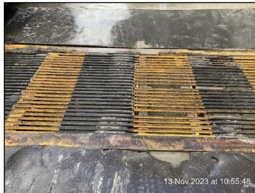
ภาพที่ 33 บ่อตกดินจากการส้างล้อ
