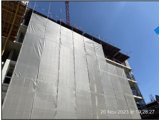
ภาพที่ 59 Sound Barrier
