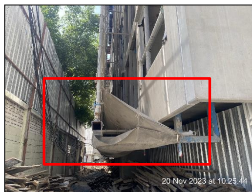
ภาพที่ 65 ผ้าใบป้องกันวัสดุตกหล่นโดยรอบอาคาร
