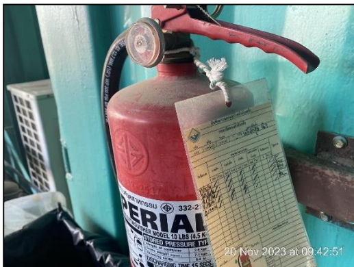
ภาพที่ 49 (ต่อ) ถังดับเพลิงและการตรวจสอบ
