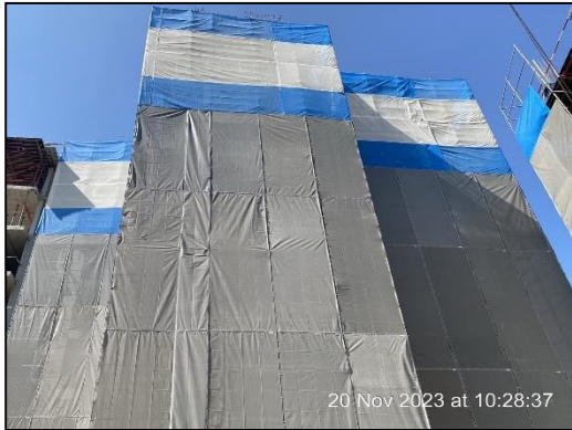
ภาพที่ 55 Mesh Sheet
