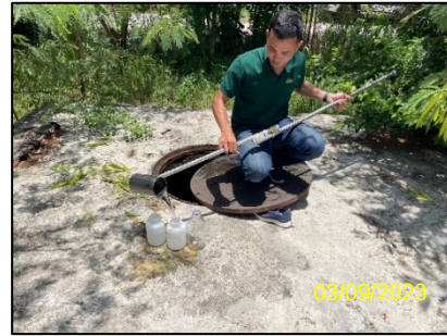
บ่อกักน้ำทิ้งหลังผ่านระบบบำบัดน้ำเสียส่วนกลาง
