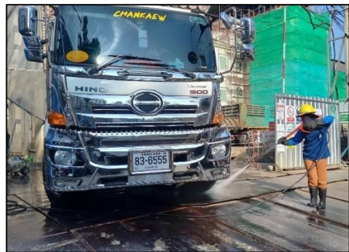
ภาพที่ 17 ล้างล้อรถด้วยน้ำแรงดันสูง
