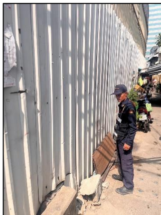
ภาพที่ 7 แผ่นเหล็กรองเครื่องจักรลดแรงสั่นสะเทือน
