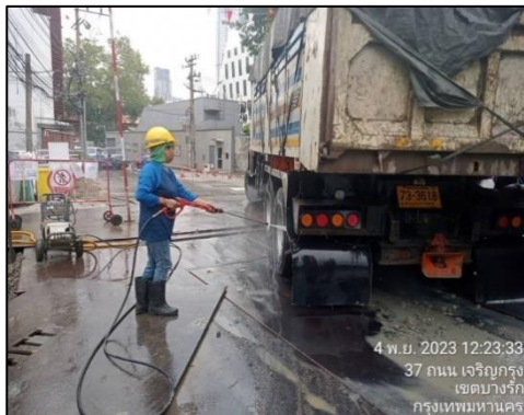
ภาพที่ 17 ล้างล้อรถด้วยน้ำแรงดันสูง
