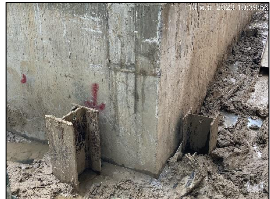
ภาพที่ 17 ระบบป้องกันดินพัง
