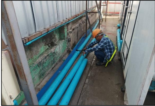
ภาพที่ 21 ท่อน้ำระบายน้ำ
