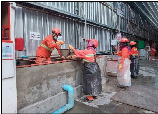
ภาพที่ 22 (ต่อ) ตรวจสอบตะกอนดิน และขุดตะกอนดินในบ่อ
