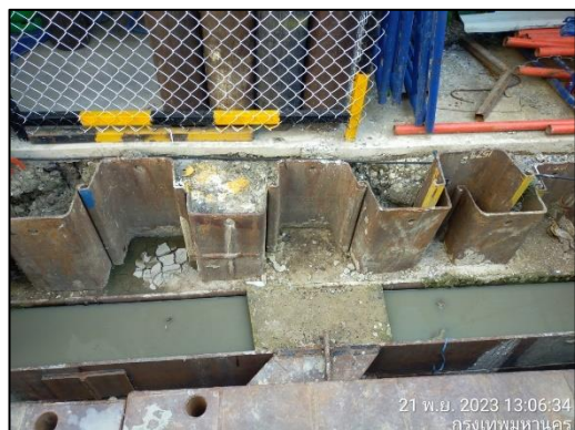
ภาพที่ 32 Sheet Pile
