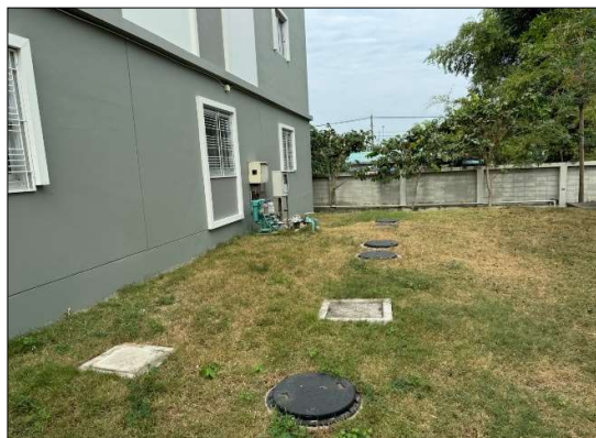
รูปที่ 2.1-14 ติดตั้งระบบบำบัดน้ำเสียแบบบ่อเติมอากาศ ปรับปรุงคุณภาพน้ำให้ผ่านเกณฑ์มาตรฐาน
