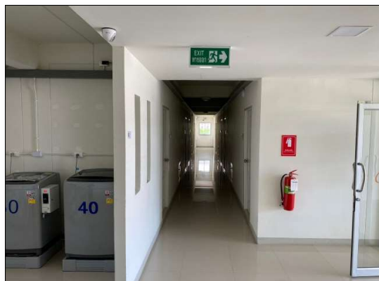
รูปที่ 2.1-30 ติดตั้งป้ายบอกตำแหน่งทางหนีไฟเป็นป้ายพลาสติกเรืองแสง
