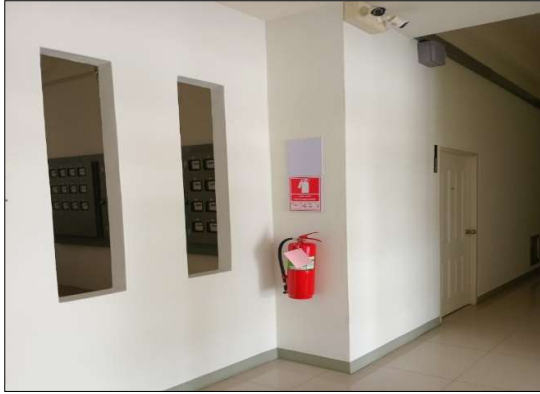
รูปที่ 2.1-31 ติดตั้งเครื่องดับเพลิงแบบมือถือ เป็นเครื่องดับเพลิงเคมีความจุ 15 ปอนด์
