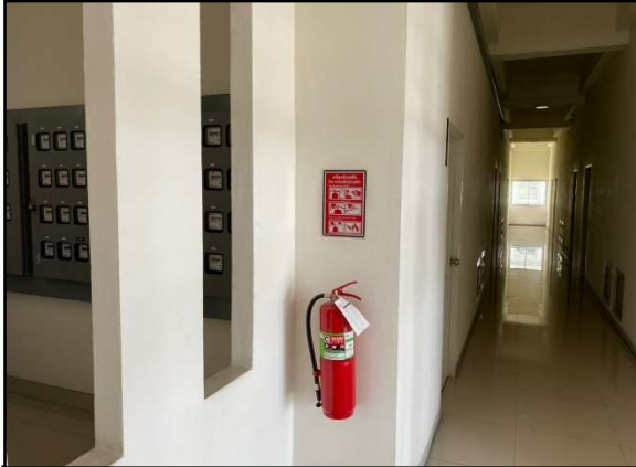
รูปที่ 2.1-25 ติดตั้งเครื่องดับเพลิงแบบมือถือ เป็นเครื่องดับเพลิงเคมีความจุ 15 ปอนด์
