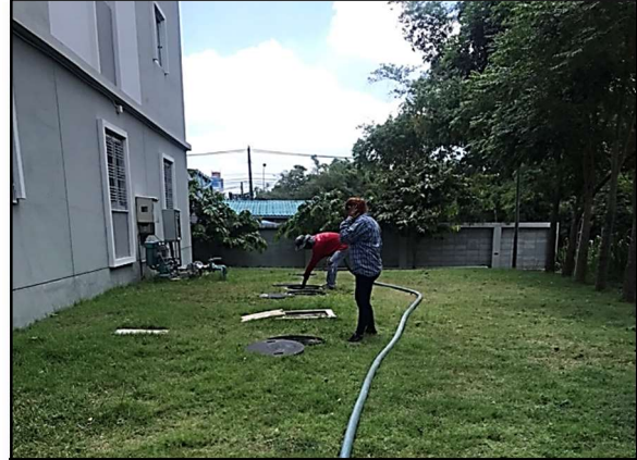
รูปที่ 2.1-14 ขุดลอกท่อระบายน้ำและบ่อบักน้ำทั้งใน เดือนเมษายนของทุกปี
