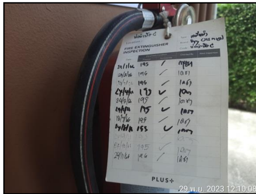
รูปที่ 35 ตรวจสอบเช็คถังดับเพลิง
