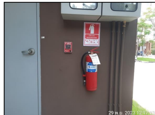
รูปที่ 32 ตู้สายฉีดน้ำดับเพลิง และถังดับเพลิงแบบมือถือ
