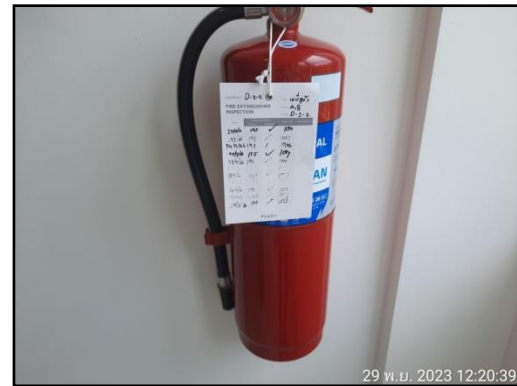
รูปที่ 35 ตรวจสอบเช็คถังดับเพลิง
