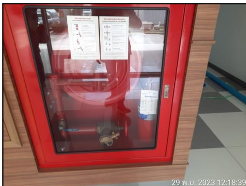
รูปที่ 32 ตู้สายฉีดน้ำดับเพลิง และถังดับเพลิงแบบมือถือ
