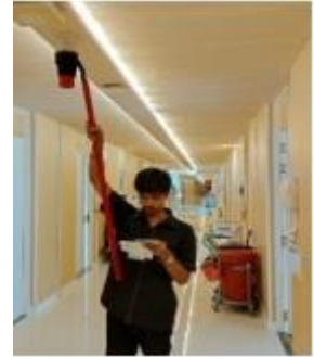
รูปที่ 3-23 ตรวจสอบสภาพอุปกรณ์แจ้งเหตุเพลิงไหม้
