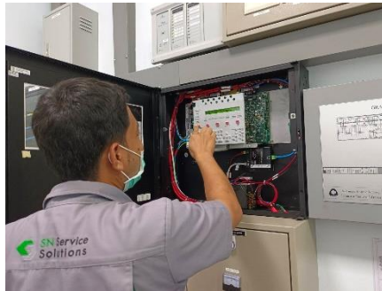
รูปที่ 3-23 ตรวจสอบสภาพอุปกรณ์แจ้งเหตุเพลิงไหม้
