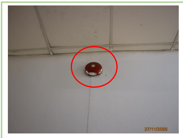
รูปที่ 3-24 Fire Alarm
