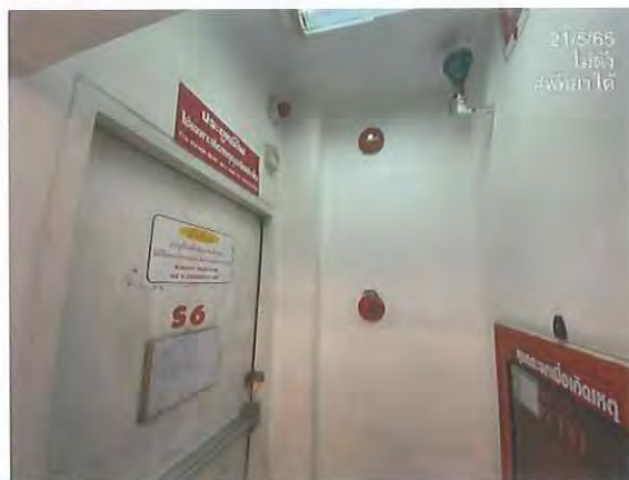
รูปที่ 3.4 ทดสอบ Manual pull station ไม่ทำงาน
