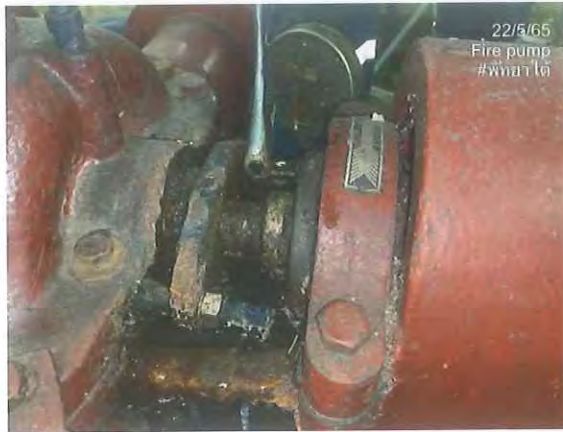
รูปที่ 2.5 ตรวจสอบพบว่า Packing seal รั่ว และ ไหม้ มีควันขึ้น ในขณะทดสอบ
