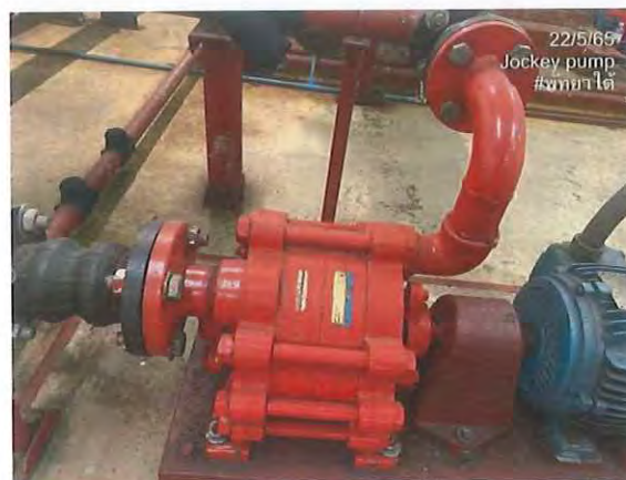
รูปที่ 2.6 ตรวจสอบสภาพทั่วไปของเครื่องสูบน้ำรักษาแรงดัน มีสภาพปกติ
