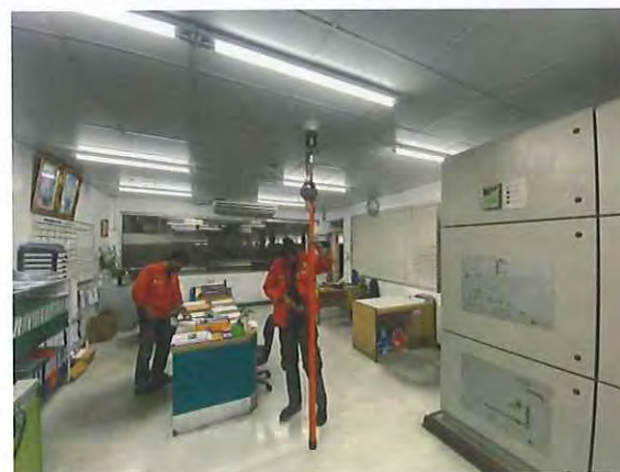
รูปที่ 2.37 ทดสอบ smoke detector พื้นที่ห้องครัว
