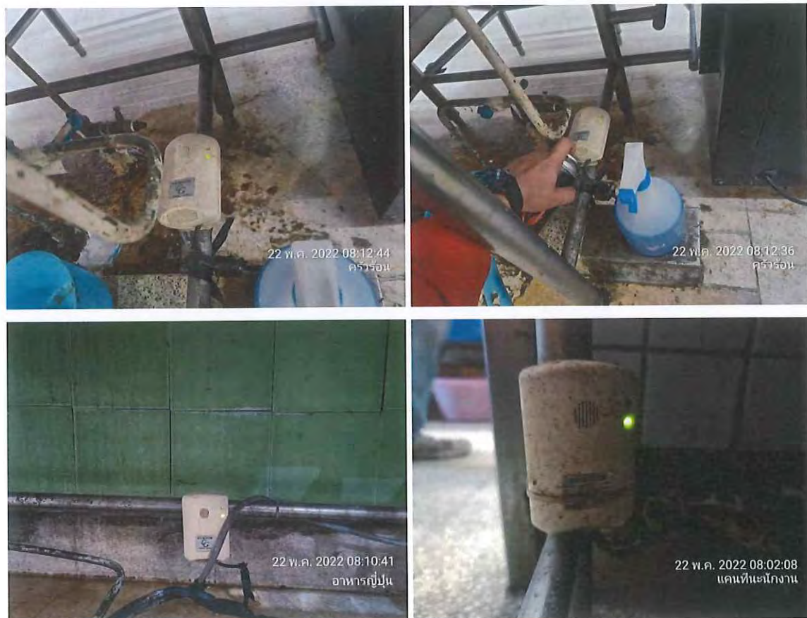
รูปที่ 2.53 ทดสอบ gas detector
