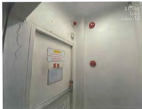
รูปที่ 3.5 ทดสอบ Alarm bell ไม่ดัง
