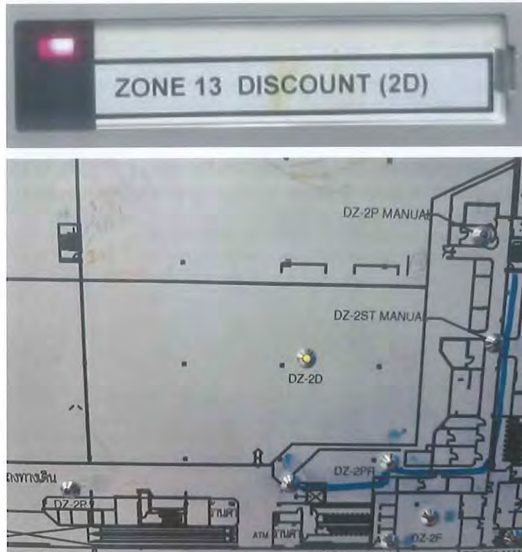
รูปที่ 2.48 ตู้ควบคุม และตู้กราฟฟิกแสดงผลแจ้งเหตุเพลิงไหม้ zone 13(DZ-2D)
