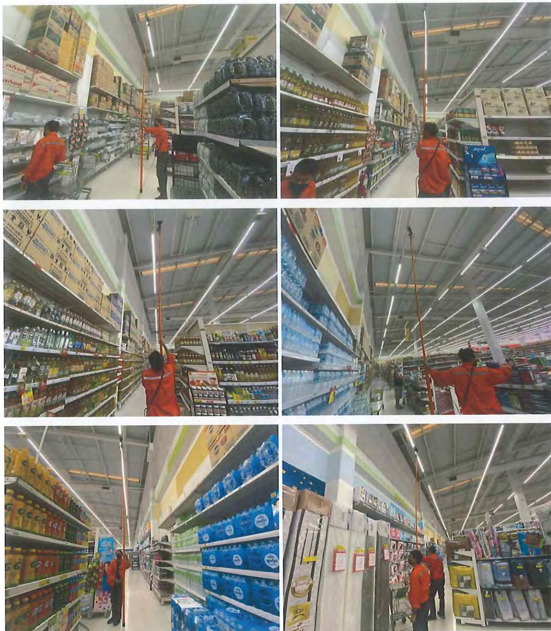
รูปที่ 2.25 ทดสอบ smoke detector พื้นที่ห้างสรรพสินค้า
