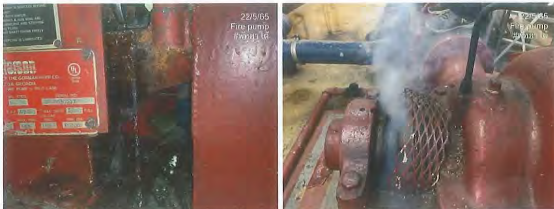
รูปที่ 3.1 Packing seal ของปั๊มสูบน้ำดับเพลิง รั่ว 1 ด้าน และไหม้ 1 ด้าน
