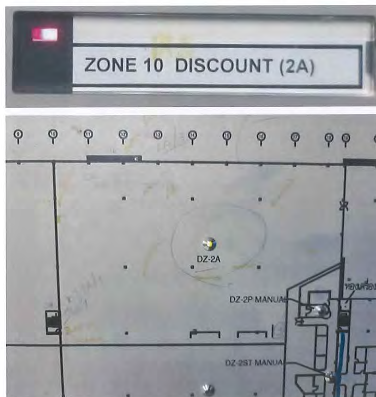
รูปที่ 2.45 ตู้ควบคุม และตู้กราฟฟิกแสดงผลแจ้งเหตุเพลิงไหม้ zone 10(DZ-2A)
