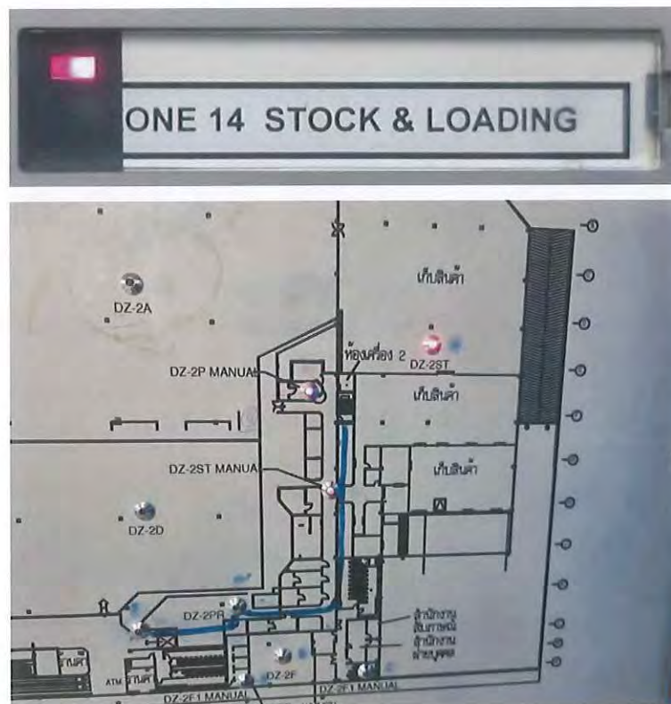
รูปที่ 2.49 ตู้ควบคุม และตู้กราฟฟิกแสดงผลแจ้งเหตุเพลิงไหม้ zone 14(STOCK&LOADING)
