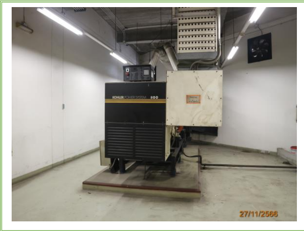
รูปที่ 3-18 เครื่องกำเนิดไฟฟ้าสำรอง
