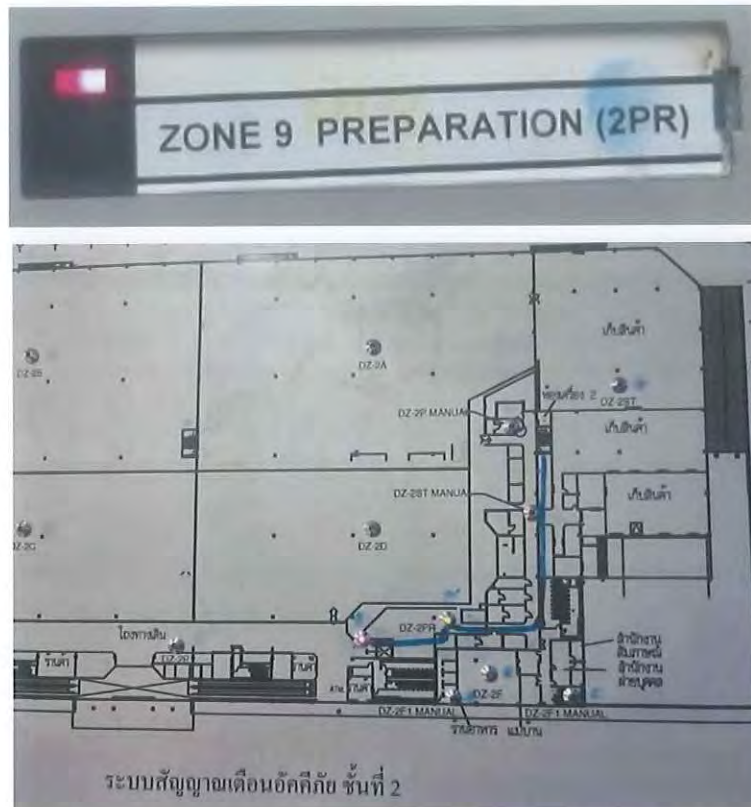
รูปที่ 2.44 ตู้ควบคุม และตู้กราฟฟิกแสดงผลแจ้งเหตุเพลิงไหม้ zone 09(DZ-2PR)
