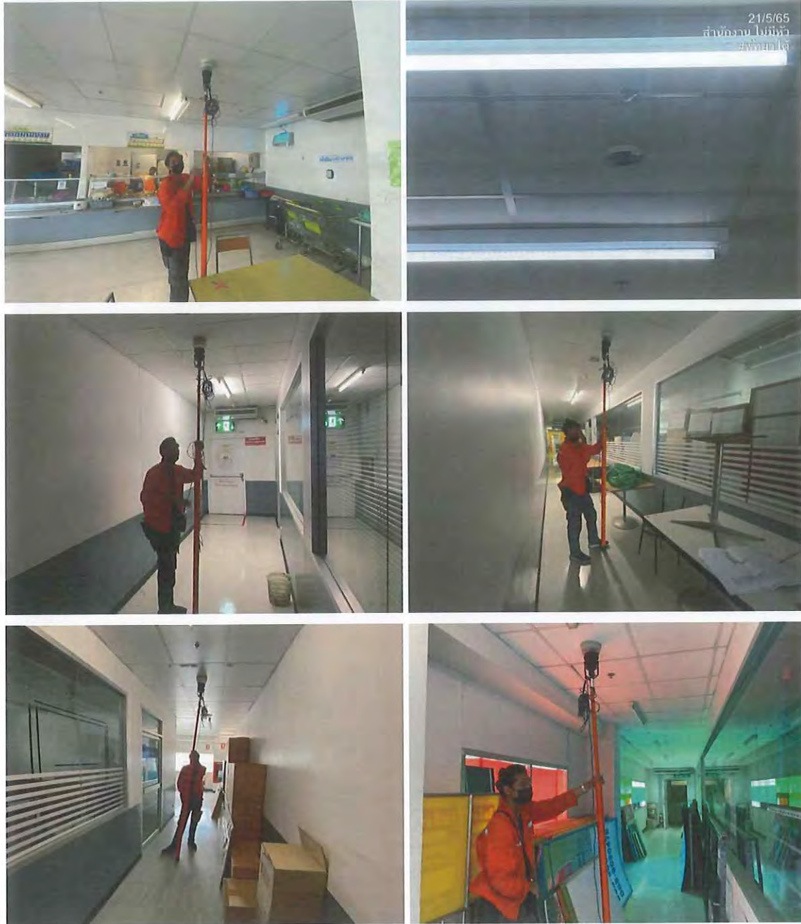
รูปที่ 2.10 ทดสอบ Smoke Detector ห้อง Canteen/ห้องสำนักงาน
