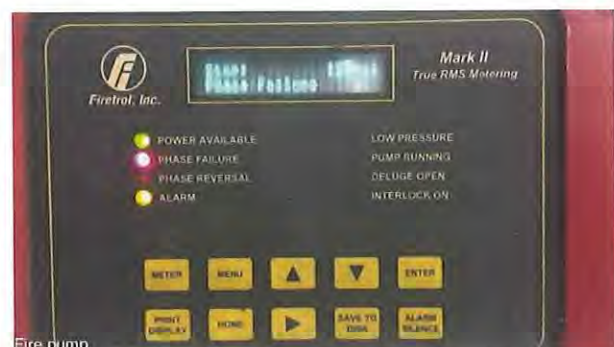
รูปที่ 1.1 Electric fire pump และ Electric fire pump controller
