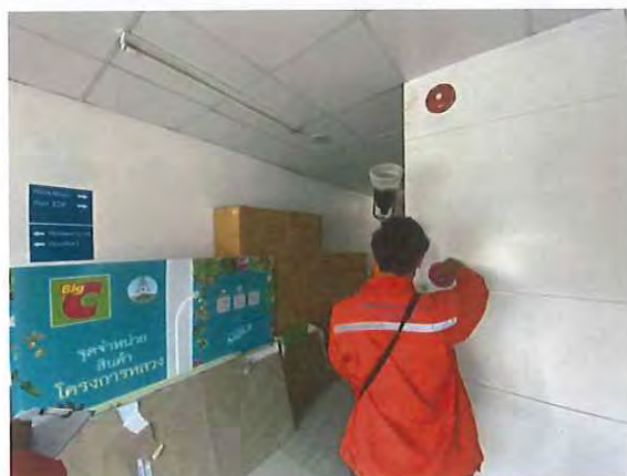
รูปที่ 2.11 ทดสอบ Manual pull station พื้นที่ออฟฟิศ
