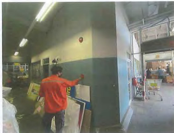
รูปที่ 2.19 ทดสอบ manual pull station ข้างห้อง GR
