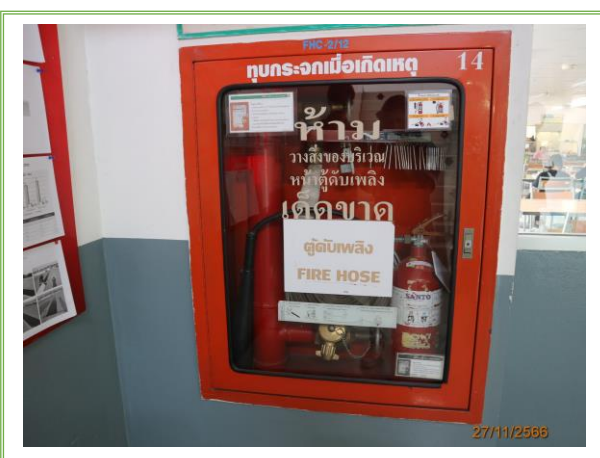
รูปที่ 3-22 ตู้สายฉีดน้ำดับเพลิง
