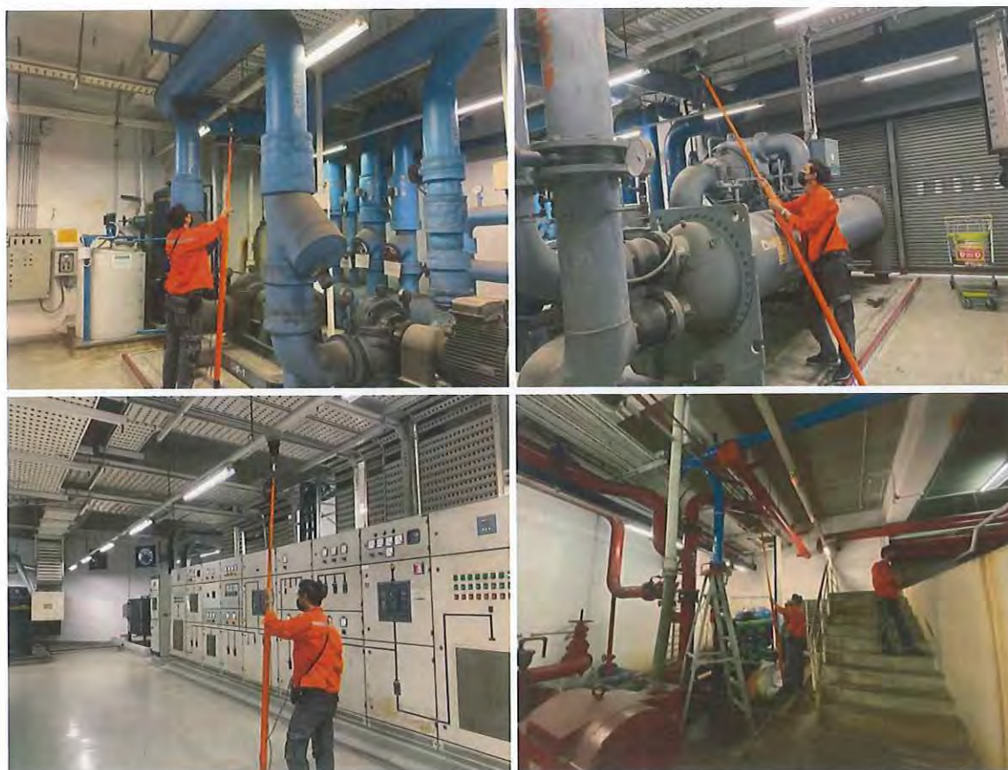
รูปที่ 2.8 ทดสอบ Smoke Detector ห้อง Chiller/ห้อง MOB/ห้อง PUMP
