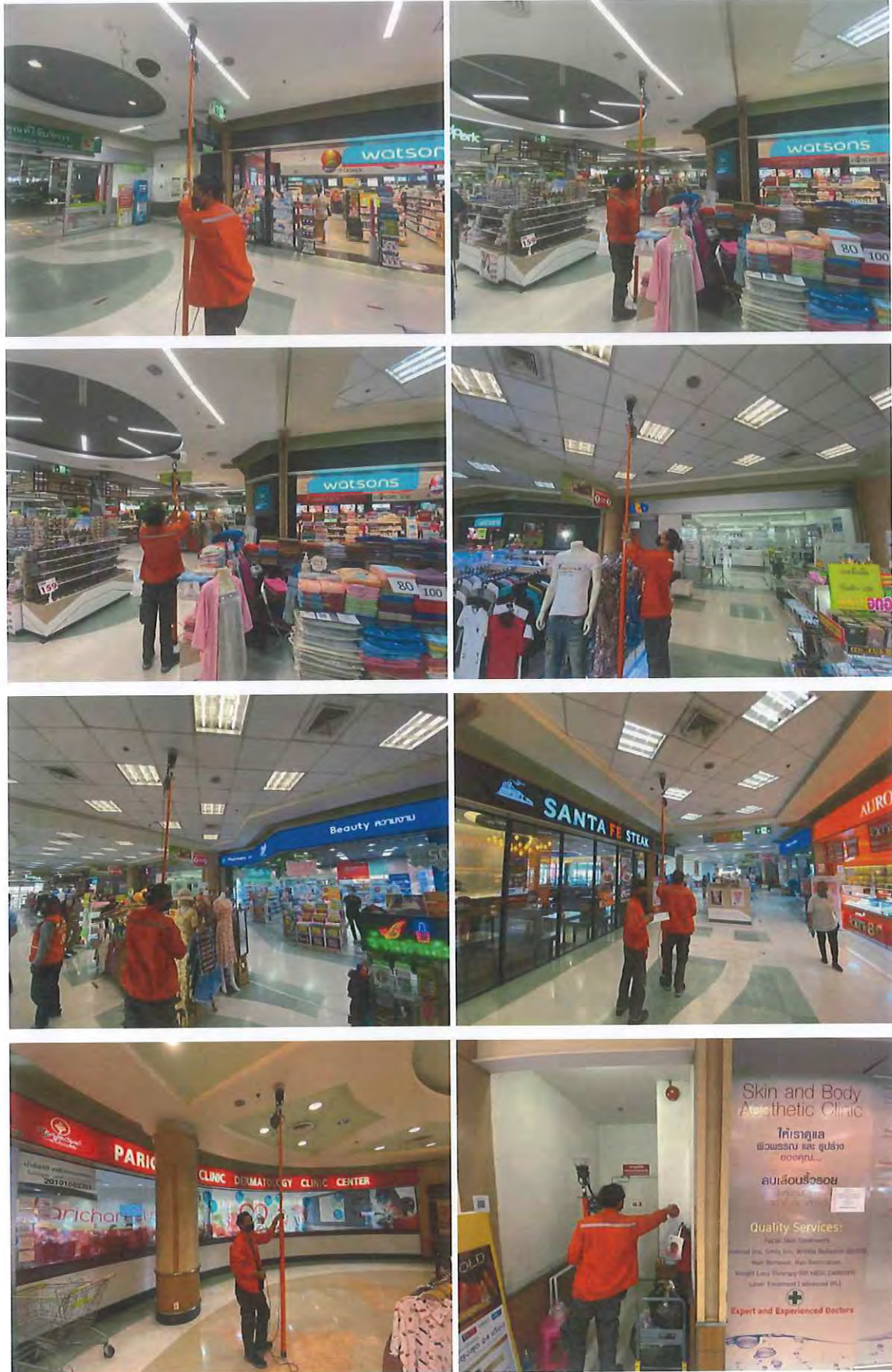
รูปที่ 2.13 ทดสอบ Smoke Detector ภายในห้างสรรพสินค้า
