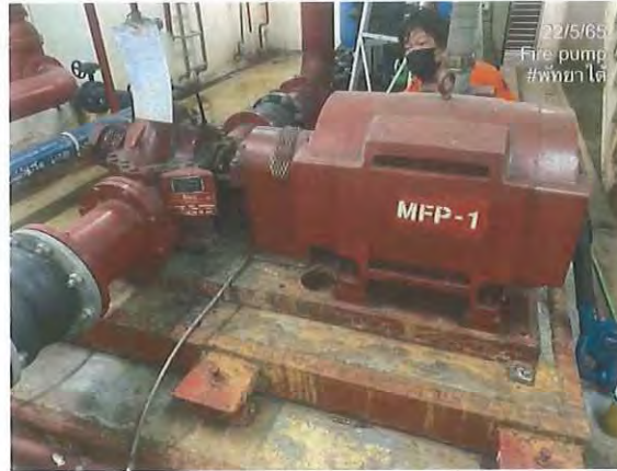
รูปที่ 2.1 ตรวจสอบสภาพทั่วไปของ Fire pump มีสภาพปกติ และทดสอบ start สามารถใช้งานได้
