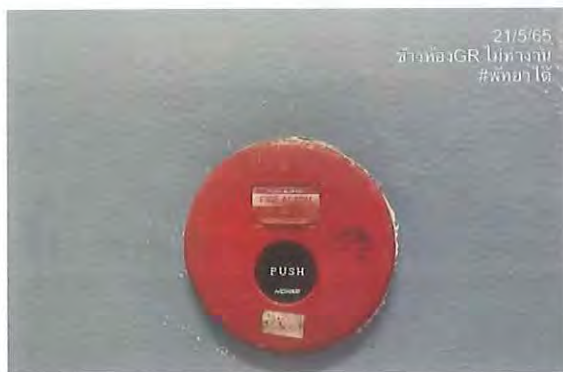
รูปที่ 3.4 ทดสอบ Manual pull station ไม่ทำงาน
