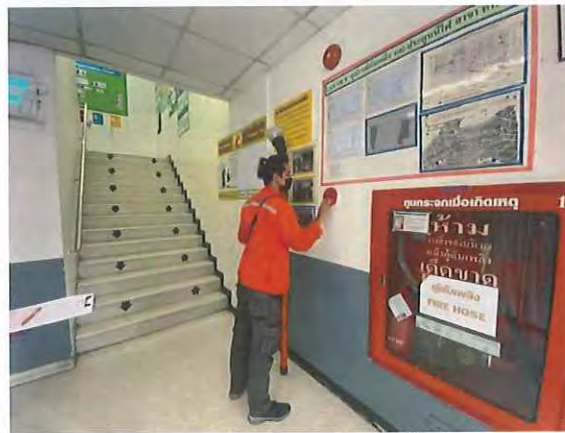
รูปที่ 2.36 ทดสอบ manual pull station พื้นที่ห้างสรรพสินค้า
