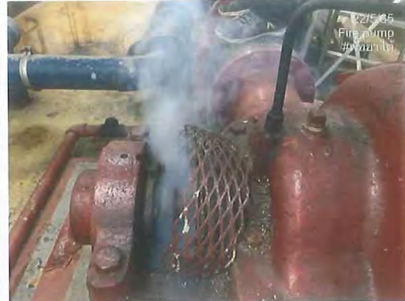
รูปที่ 2.5 ตรวจสอบพบว่า Packing seal รั่ว และ ไหม้ มีควันขึ้น ในขณะทดสอบ
