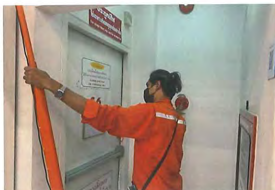
รูปที่ 2.26 ทดสอบ manual pull station พื้นที่ห้างสรรพสินค้า
