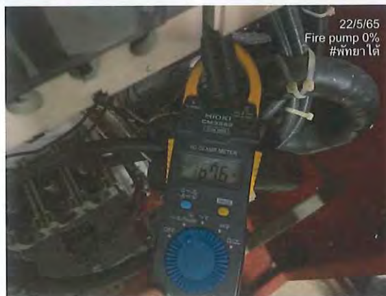
รูปที่ 2.2 ตรวจสอบค่ากระแสไฟฟ้าตัวควบคุมเครื่องสูบน้ำ ขณะเครื่องสูบน้ำทำงาน
