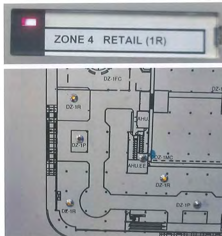
รูปที่ 2.41 ตู้ควบคุม และตู้กราฟฟิกแสดงผลแจ้งเหตุเพลิงไหม้ zone 04(DZ-1R)
