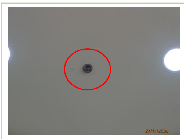
รูปที่ 3-26 Sprinkler
