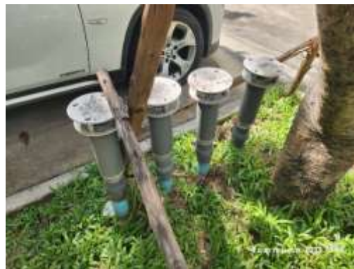
รูปที่ 55 การกำจัดก๊าซมีเทนและละอองน้ำเสีย (Aerosol)
