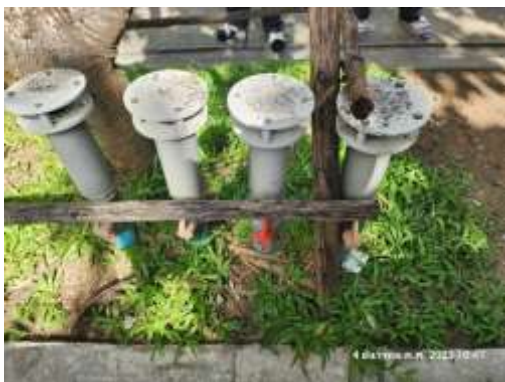
รูปที่ 55 การกำจัดก๊าซมีเทนและละอองน้ำเสีย (Aerosol)
