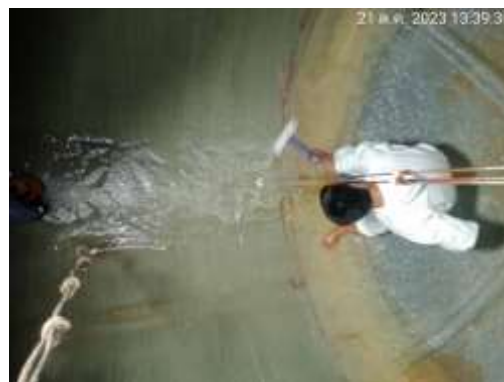
รูปที่ 54 ทำความสะอาดถังสำรองน้ำ
