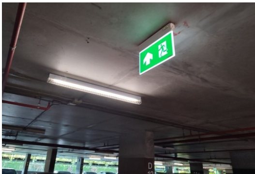
ภาพที่ 3-38 ป้ายบอกทางหนีไฟ และหลอดไฟ LED ประหยัดพลังงาน
