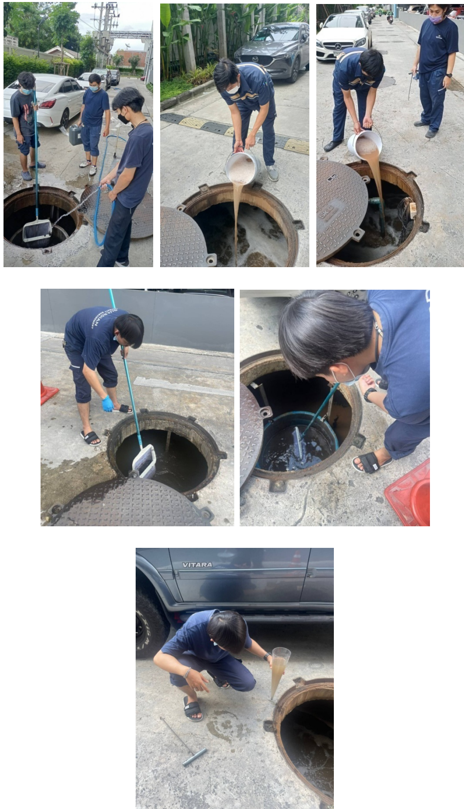
ภาพที่ 3-25 คูตะกอนในระบบบำบัดน้ำเสียและบำรุงรักษาระบบบำบัดน้ำเสียของโครงการ
