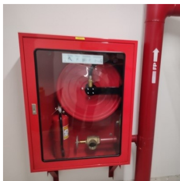
ภาพที่ 3-10 ติดตั้งอุปกรณ์ป้องกันอัคคีภัย
