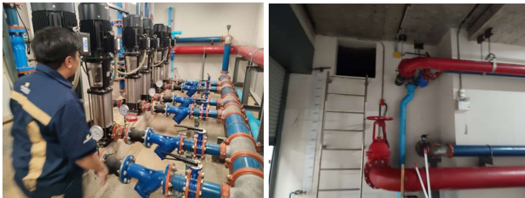
ภาพที่ 3-22 ห้องเครื่องปั๊มน้ำไม่มีจุดรั่วซึม ถึงสำรองน้ำใช้ไม่มีรอยแตร้าว
