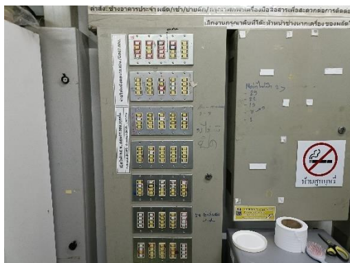
ระบบเปิดปิดไฟบบสวิตช์แยก
