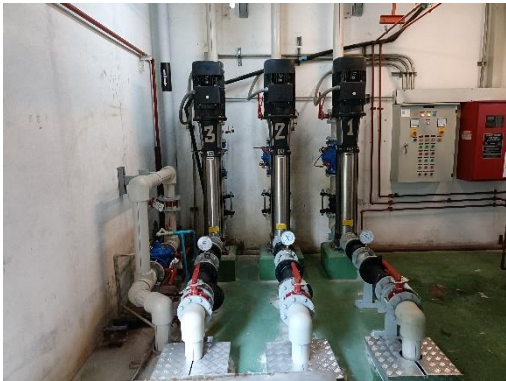
ปั๊มสูบน้ำใช้ขึ้นถังเก็บน้ำคาตฟ้า
