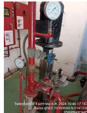
ตรวจสอบปั้มน้ำดับเพลิง
