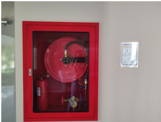
ภาพที่ 3-18 ท่อขึ้นและตู้เก็บสายฉีดน้ำดับเพลิงและอุปกรณ์
