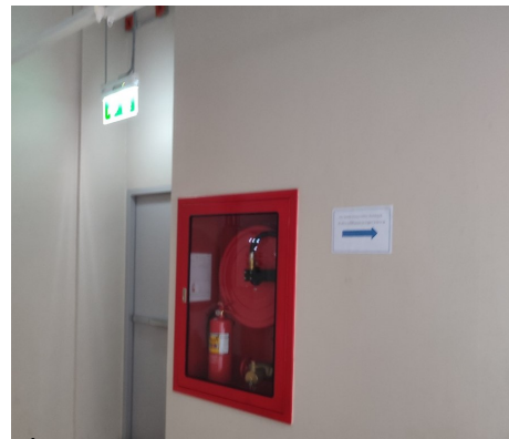
ภาพที่ 3-18 ท่อขึ้นและตู้เก็บสายฉีดน้ำดับเพลิงและอุปกรณ์
