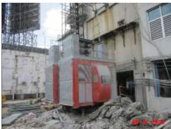
รูปที่ 29 ลิฟต์ขนส่งวัสดุก่อสร้าง
