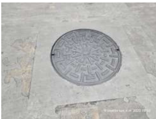
รูปที่ 47 ฝาบ่อระบบบำบัดน้ำเสียปิดมิดชิด
