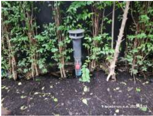
รูปที่ 52 ระบบจำกัดก๊าซซีเมนและละอองลอย
