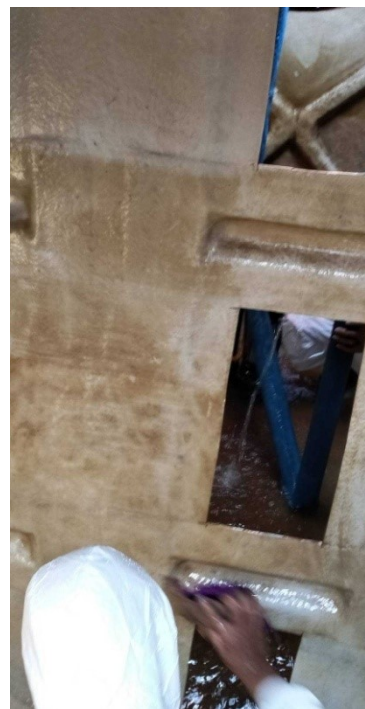
ภาพที่ 4-33 ล้างบ่อสำรองน้ำใช้ที่ชั้นดาดฟ้า
