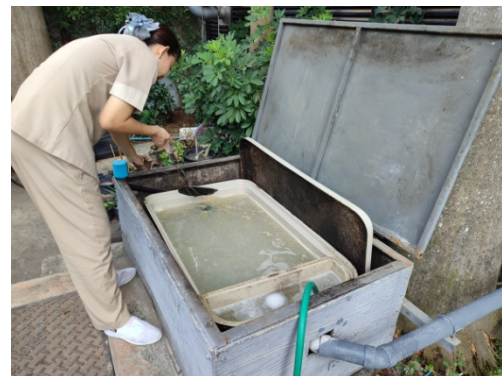
ภาพที่ 4-35 ตักไขมันที่ติดกับไขมันจากน้ำทิ้งห้องครัว
