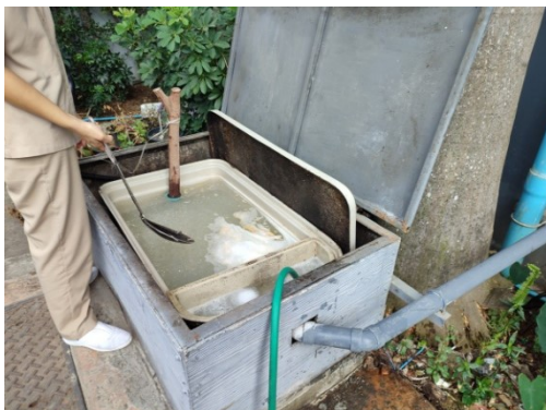
ภาพที่ 4-35 ตักไขมันที่ติดกับไขมันจากน้ำทิ้งห้องครัว
