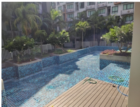
ภาพที่ 4-34 ปิดซ่อมแซมยาแนวพื้นกระเบื้องสระว่ายน้ำ น้ำนำออก ผึ่งสระให้แห้งสนิท
