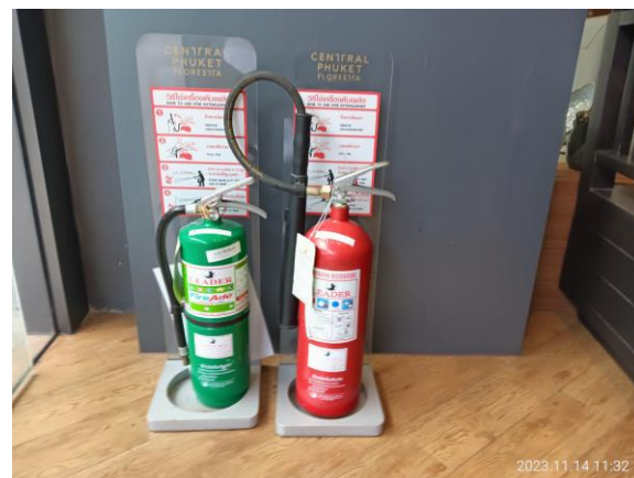
รูปที่ 3-49 อุปกรณ์ดับเพลิงแบบมือถือ
