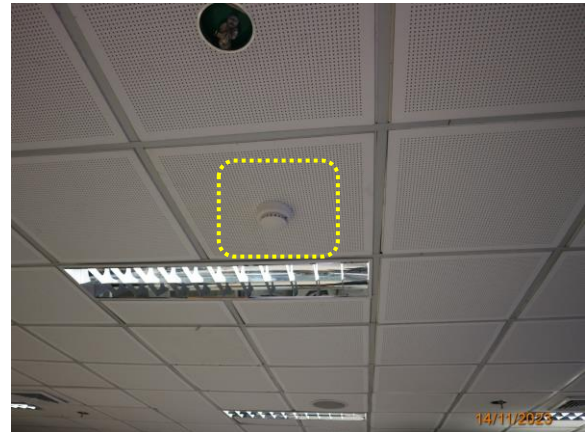
รูปที่ 3-51 อุปกรณ์ตรวจจับควัน
