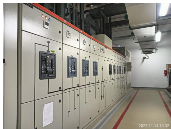
รูปที่ 3-43 Circuit Breaker
