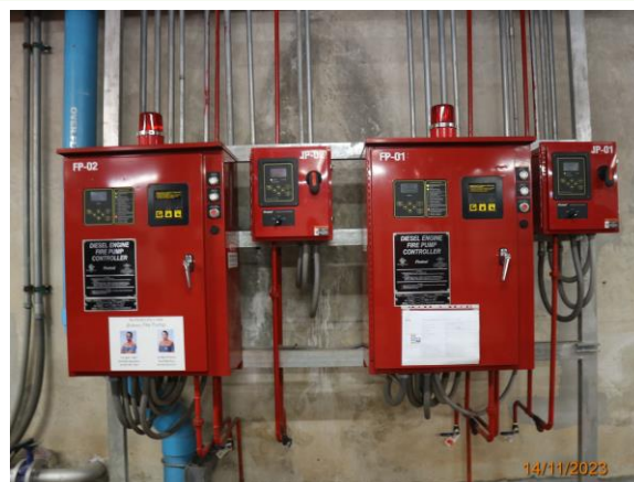
รูปที่ 3-57 ระบบปั๊มดับเพลิงอัตโนมัติ
