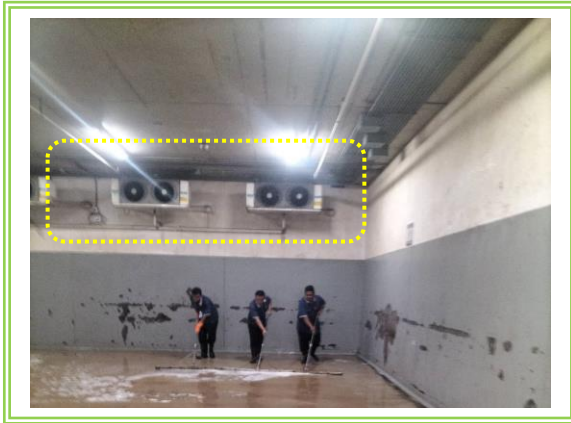
รูปที่ 2.5-5 ระบบปรับอากาศในห้องพักขยะ
