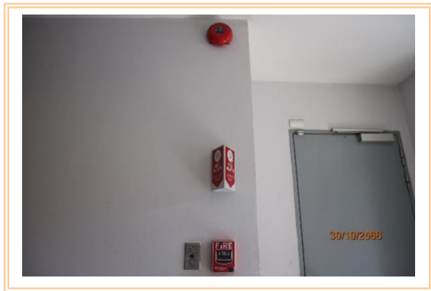
รูปที่ 2.9-1 ระบบสัญญาณเตือนเพลิงไหม้
