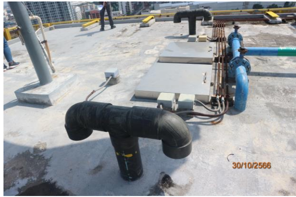
รูปที่ 3-13 ท่อระบายอากาศ
