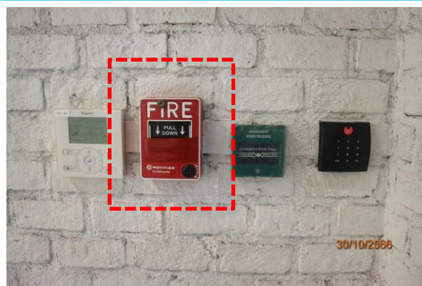
รูปที่ 3-39 อุปกรณ์แจ้งเหตุเพลิงไหม้แบบใช้มือ
