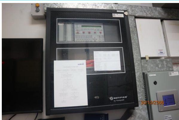
รูปที่ 3-38 Fire Alarm Control Panel ห้องควบคุม
