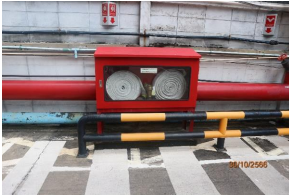
รูปที่ 2.9-5 ตู้เก็บสายฉีดน้ำดับเพลิงพร้อมอุปกรณ์
