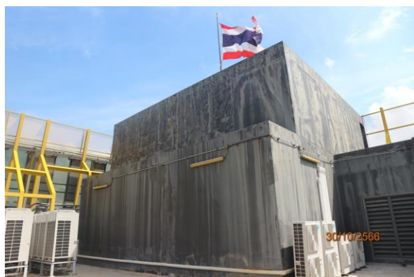
รูปที่ 3-21 ถังสำรองน้ำใช้ของอาคารสำนักงาน
