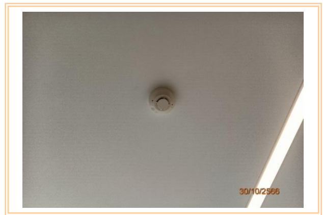
รูปที่ 2.9-2 Smoke Detector
