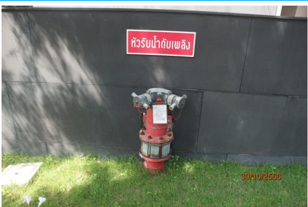
รูปที่ 3-42 หัวรับน้ำดับเพลิงภายนอกอาคาร
