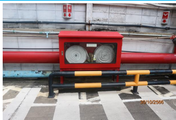
รูปที่ 3-41 ตู้เก็บสายน้ำดับเพลิงพร้อมอุปกรณ์
