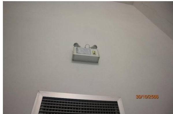
รูปที่ 2.9-8 ไฟส่องสว่างฉุกเฉิน (Emergency Light)
