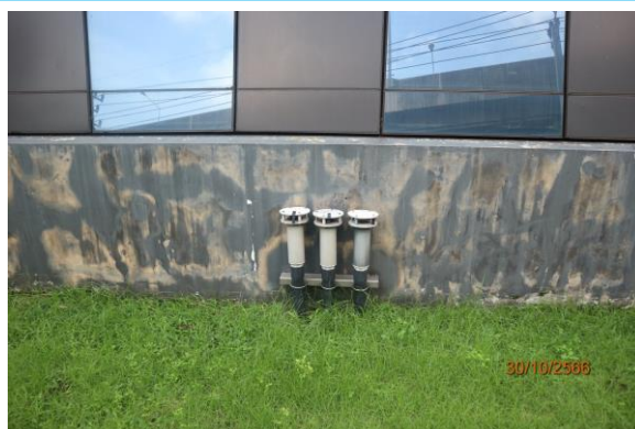
รูปที่ 3-11 ระบบกำจัดละอองน้ำเสีย (Aerosol)
