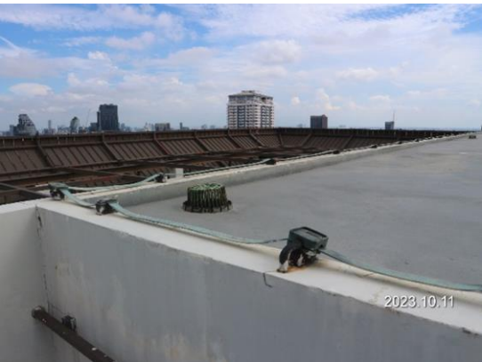
รูปที่ 3.1-35 ระบบป้องกันฟ้าผ่า
