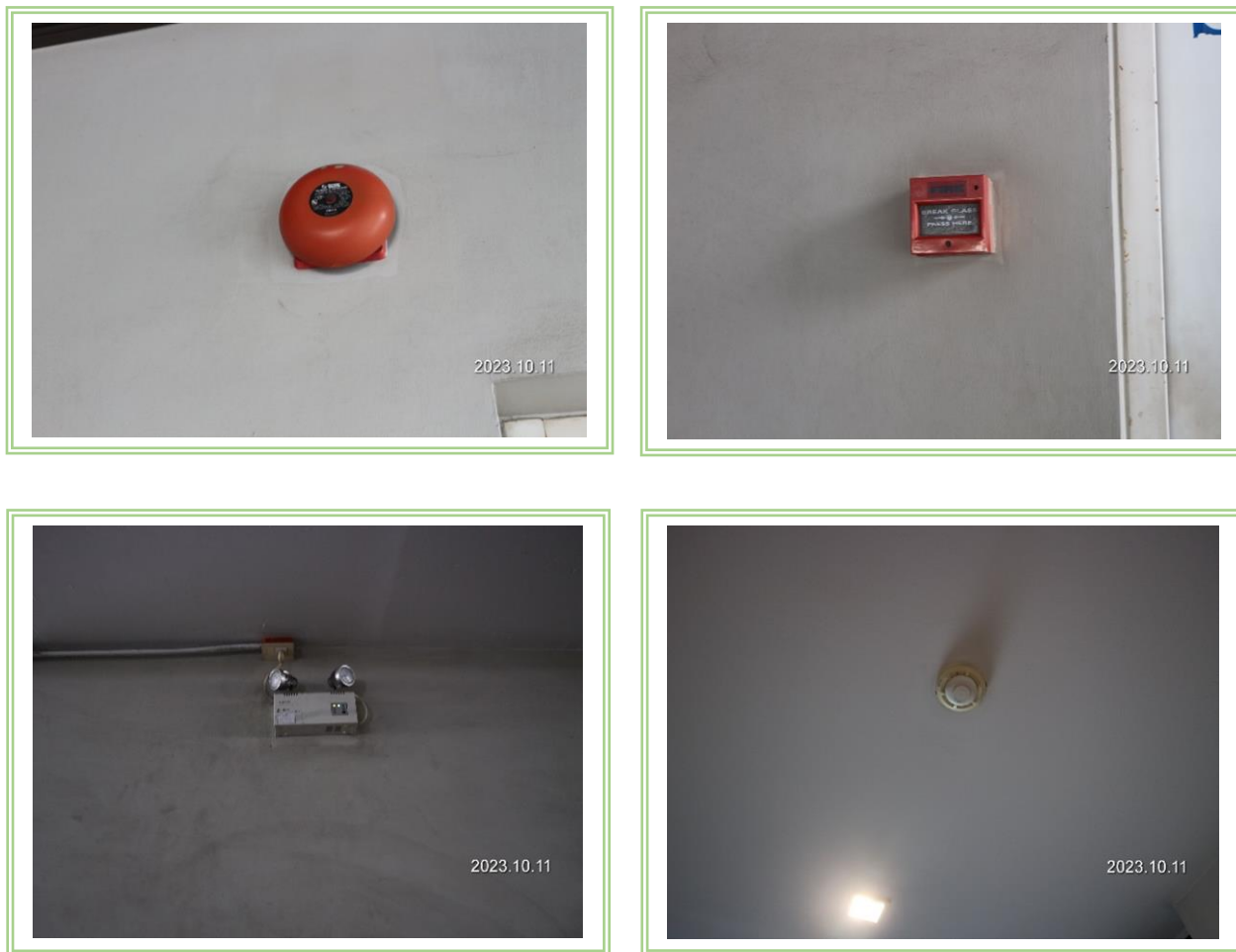
รูปที่ 2.5-11 ระบบสัญญาณเตือนอัคคีภัย
