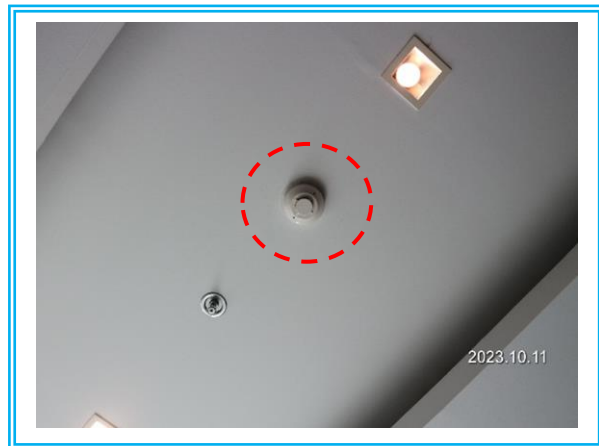
รูปที่ 3.1-19 Smoke Detector
