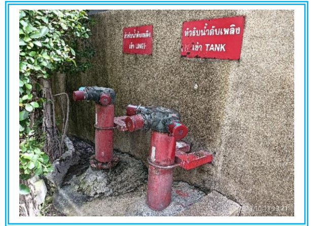
รูปที่ 3.1-18 หัวรับน้ำดับเพลิงติดตั้งภายนอกอาคาร
