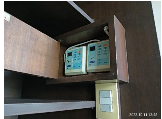
รูปที่ 3.1-34 การติดตั้งสวิทช์เปิด/ปิดเครื่องปรับอากาศ แยกออกจากกันในแต่ละพื้นที่ของอาคาร
