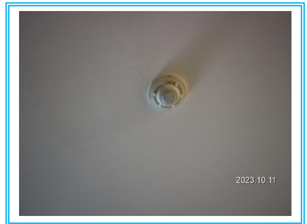
รูปที่ 3.1-20 Heat Detector
