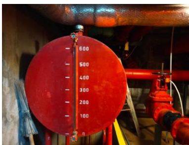
ระบบ Engine ใช้น้ำมันเดินปั๊มฉีดน้ำดับเพลิงกรณีไฟฟ้าดับ
