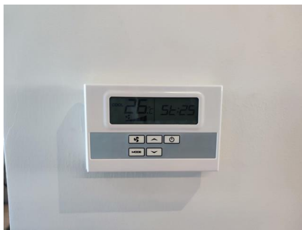
ชุดควบคุมอุณหภูมิห้องปรับอากาศ
