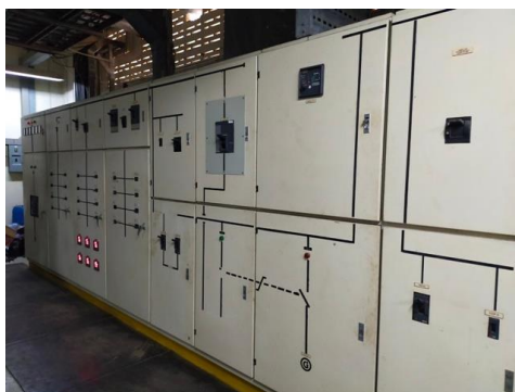
ตู้ควบคุมระบบไฟฟ้า (Power Monitoring) ที่ตู้ MDB
