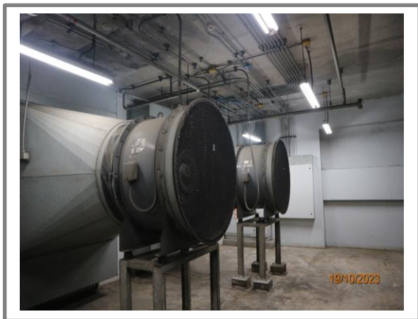
รูปที่ 3.1-7 เครื่องดูดและระบายอากาศบริเวณลานจอดรถ
