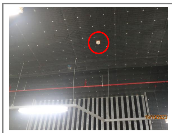
รูปที่ 3.1-41 เครื่องตรวจจับควันภายในห้องเครื่องไฟฟ้า
