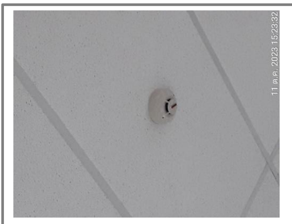
รูปที่ 3.1-52 เครื่องตรวจจับความร้อน
