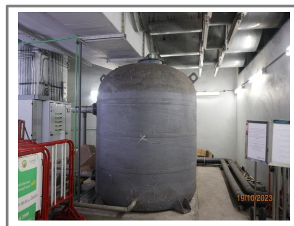
รูปที่ 3.1-14 ถังบำบัดก๊าซมีเทน
