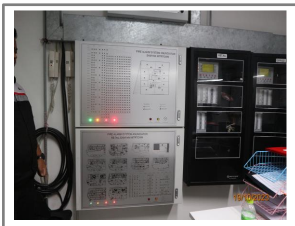
รูปที่ 3.1-51 แผงควบคุมระบบอัคคีภัย
