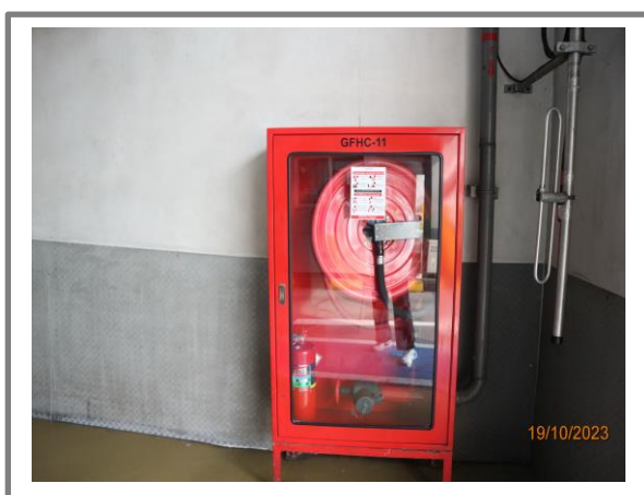
รูปที่ 3.1-47 ตู้เก็บสายฉีดน้ำดับเพลิง
