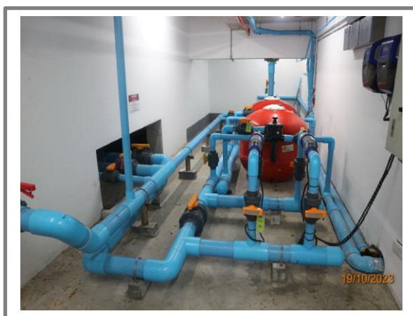
รูปที่ 3.1-23 ระบบกรองของสระว่ายน้ำ
