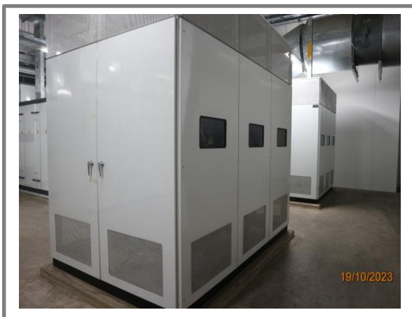
รูปที่ 3.1-39 หม้อแปลงไฟฟ้า
