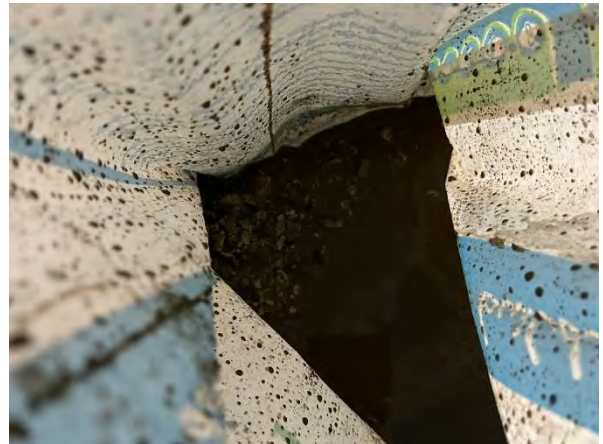
ตะกอนที่อยู่ภายในบ่อน้ำก่อนทำความสะอาด
