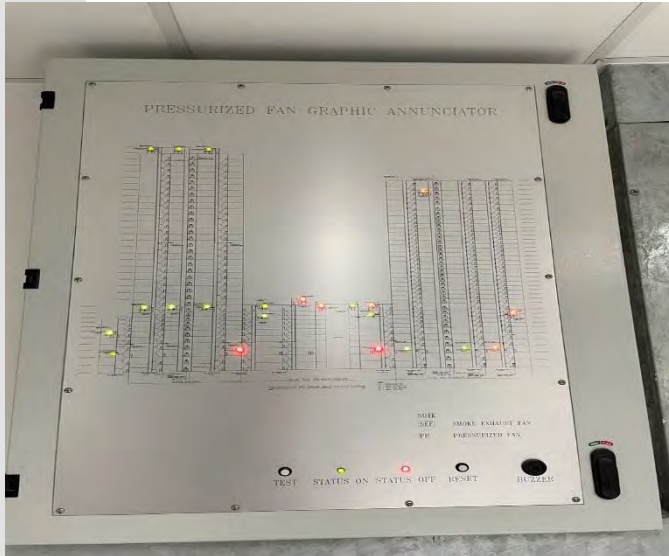
Stair Pressurized Fan ทำงาน (Retail Zone) (ST-A2 & Fire Man Lift )
