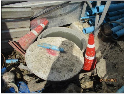
รูปที่ 95 ถังบำบัดน้ำเสียสำเร็จรูปในพื้นที่ก่อสร้าง
