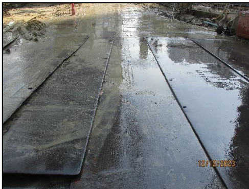
รูปที่ 24 แผ่นเหล็กปูเส้นทางเดินรถ ภายในพื้นที่ก่อสร้าง
