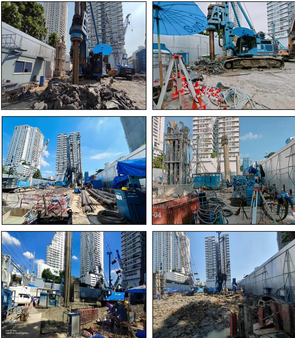
รูปที่ 30 เครื่องเจาะเสาเข็ม
