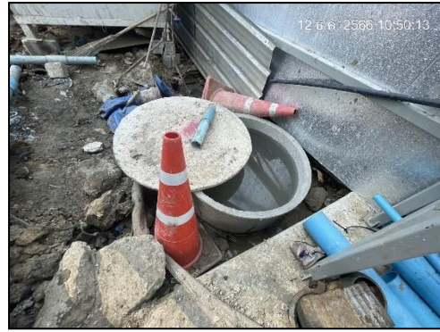
รูปที่ 95 ถังบำบัดน้ำเสียสำเร็จรูปในพื้นที่ก่อสร้าง
