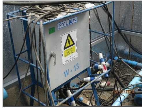
รูปที่ 62 แผงควบคุมไฟฟ้า และเครื่องตัดกระแสไฟฟ้าอัตโนมัติ
