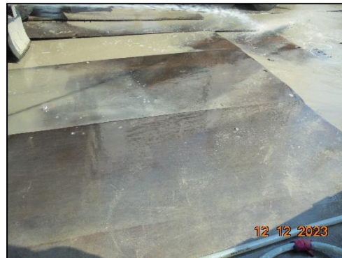
รูปที่ 24 แผ่นเหล็กปูเส้นทางเดินรถ ภายในพื้นที่ก่อสร้าง
