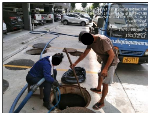
รูปที่ 25 เจ้าหน้าที่สูบล้างปลักอุดตัน
