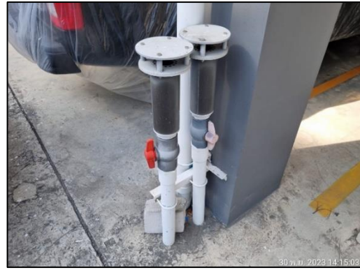
รูปที่ 28 เครื่องเติมอากาศระบบบำบัดน้ำเสีย
