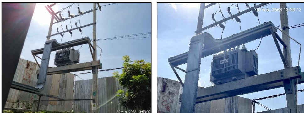
รูปที่ 74 หม้อแปลงไฟฟ้าภายในโครงการ
