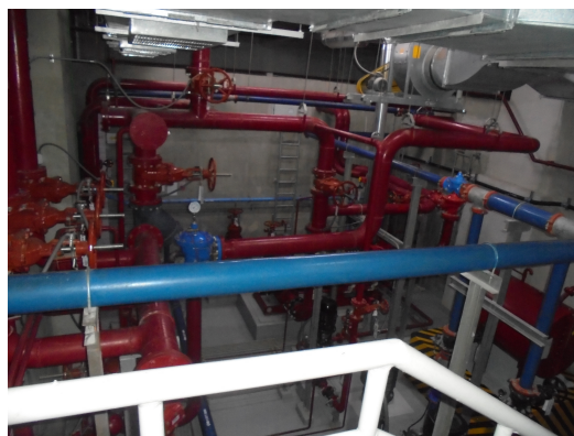
ภาพที่ 3-18 ห้องเครื่องปั้มน้ำดับเพลิง
