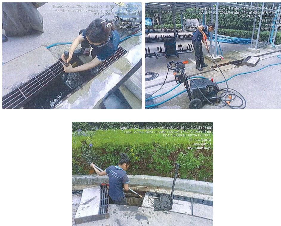
ภาพที่ 3-36 ขุดลอกท่อระบายน้ำและบ่อพักน้ำ
