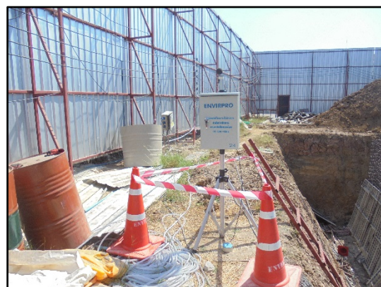
รูปที่ 3.2-1 จุดตรวจวัดระดับเสียงทั่วไป บริเวณพื้นที่ก่อสร้าง ด้านที่อยู่ใกล้อาคารข้างเคียงมากที่สุด
