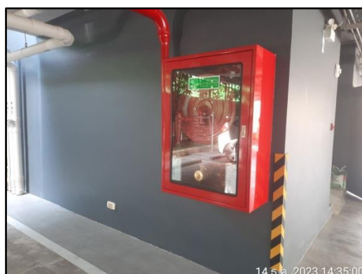
รูปที่ 48 ถังดับเพลิงแบบมือถือ และ ตู้เก็บสายฉีดน้ำดับเพลิงพร้อมอุปกรณ์
