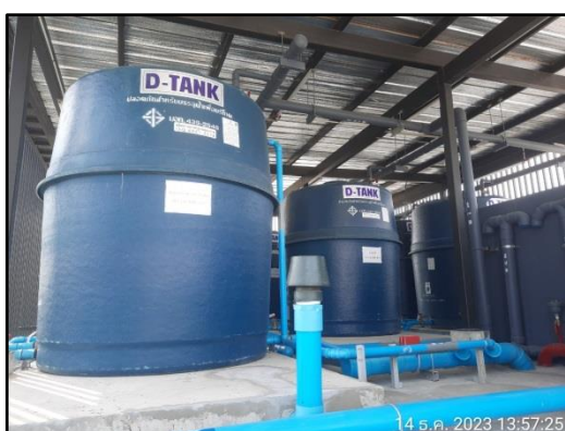
รูปที่ 15 ถังสำรองน้ำใช้ในโครงการ
