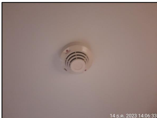
รูปที่ 50 (ต่อ) อุปกรณ์ตรวจจับควัน
