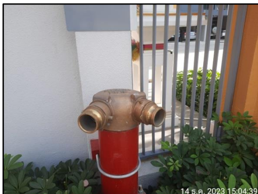
รูปที่ 47 หัวรับน้ำดับเพลิงภายนอกอาคาร
