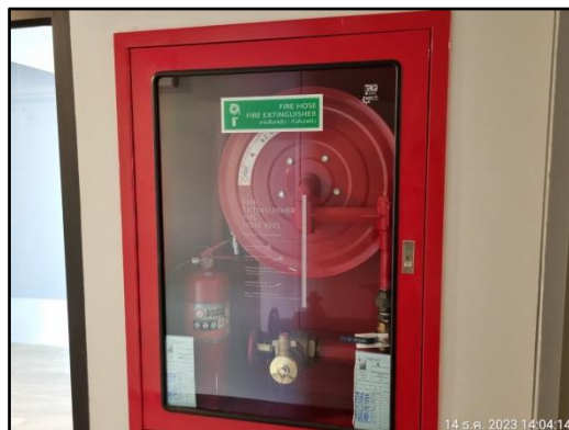
รูปที่ 48 (ต่อ) ถังดับเพลิงแบบมือถือ และ ตู้เก็บสายฉีดน้ำดับเพลิงพร้อมอุปกรณ์
