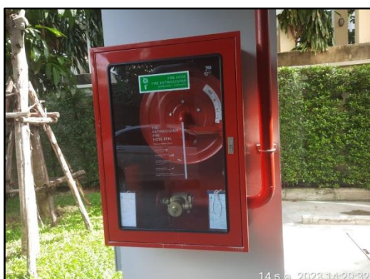
รูปที่ 48 ถังดับเพลิงแบบมือถือ และ ตู้เก็บสายฉีดน้ำดับเพลิงพร้อมอุปกรณ์
