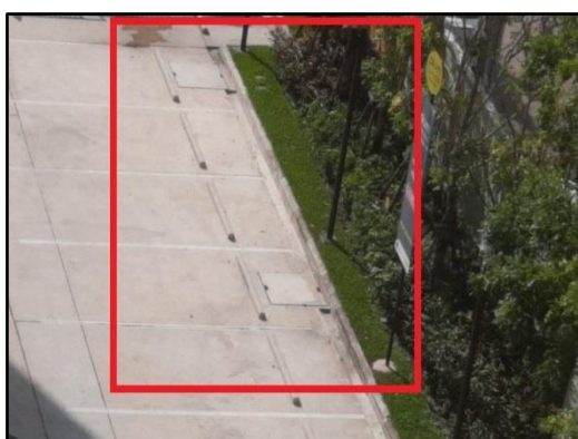
รูปที่ 4 ท่อระบายน้ำทำหน้าที่รวบรวมน้ำฝน
