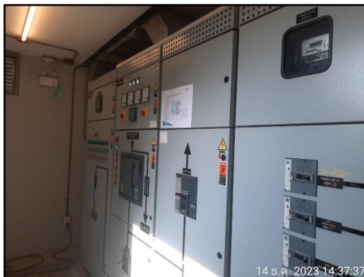
รูปที่ 36 ห้องสวิตช์บอร์ดแรงสูงชนิดติดตั้งภายในอาคาร (MDB)
