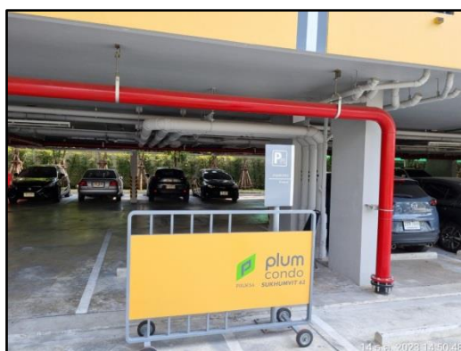
รูปที่ 46 ท่อเย็นรับน้ำดับเพลิงจากหัวรับน้ำดับเพลิงภายนอกอาคาร
