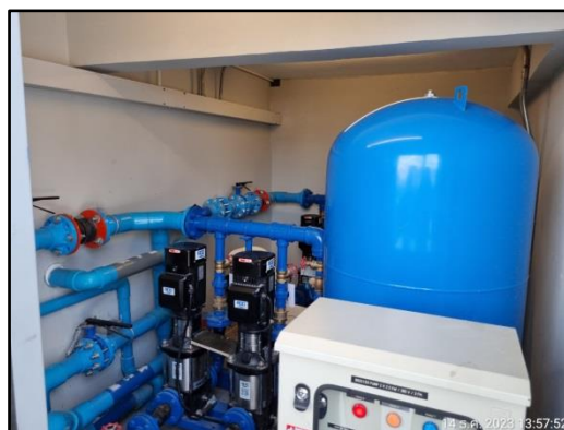
รูปที่ 17 ระบบเครื่องปั้มน้ำใช้ในโครงการ
