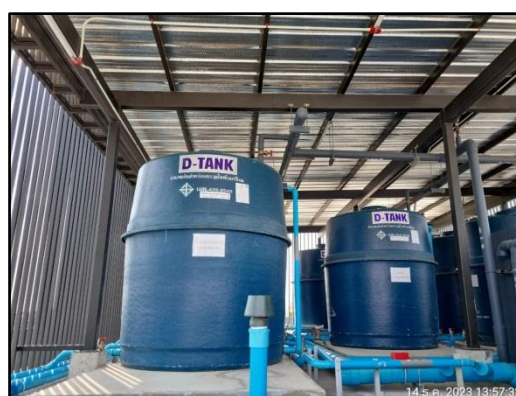
รูปที่ 15 ถังสำรองน้ำใช้ในโครงการ
