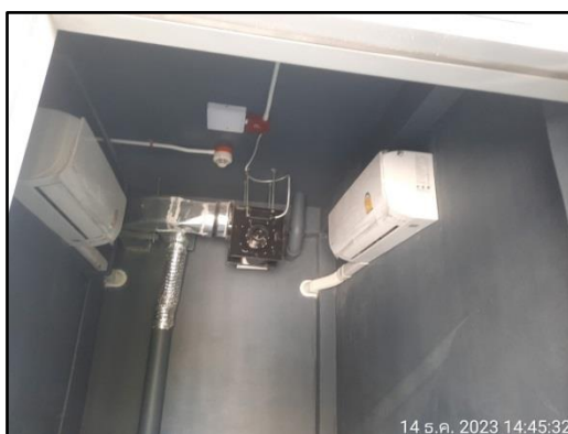
รูปที่ 32 ระบบปรับอากาศภายในห้องพักมูลฝอยเปียก
