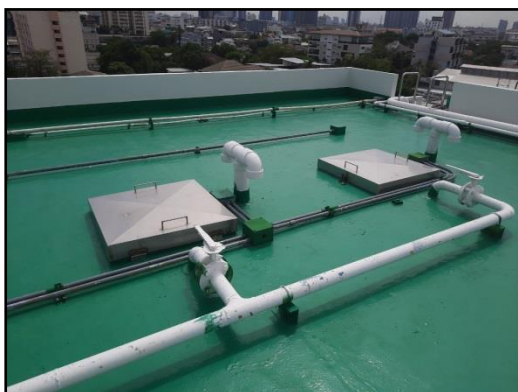
รูปที่ 17 ถังสำรองน้ำใช้ชั้นคาเฟ่
