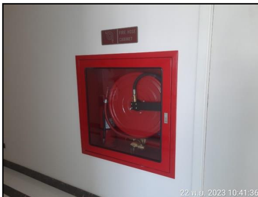
รูปที่ 50 ระบบท่อขึ้น หัวรับจ่ายน้ำดับเพลิง และตู้เก็บสายฉีดน้ำดับเพลิง
