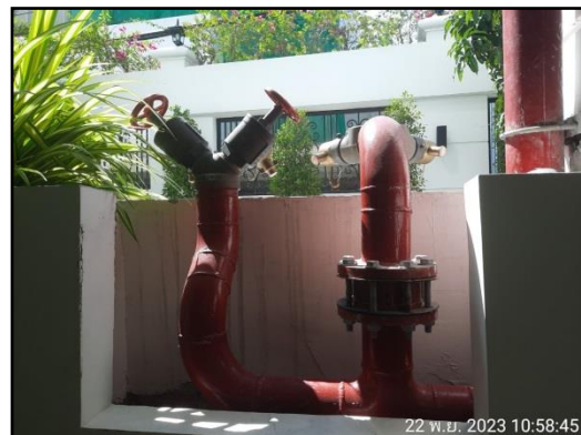
รูปที่ 50 ระบบท่อขึ้น หัวรับจ่ายน้ำดับเพลิง และตู้เก็บสายฉีดน้ำดับเพลิง
