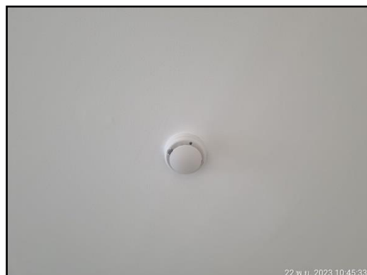
รูปที่ 44 อุปกรณ์ตรวจจับควัน
