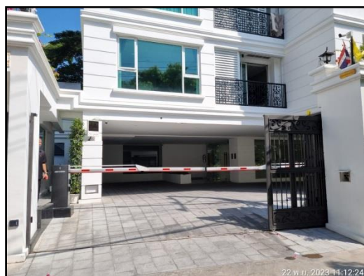
รูปที่ 12 ระบบแขนกั้นรถยนต์ควบคุมการเข้าออกของรถ
