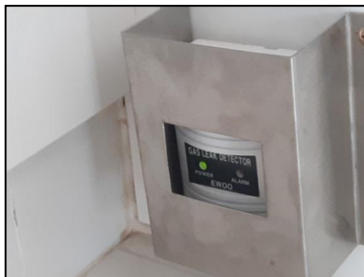
รูปที่ 47 Gas Leak Detector
