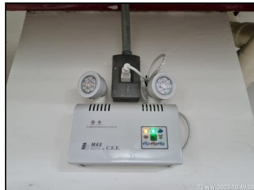
รูปที่ 46 ไฟฉุกเฉินอัตโนมัติ
