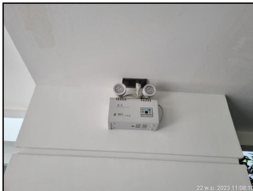
รูปที่ 46 ไฟฉุกเฉินอัตโนมัติ
