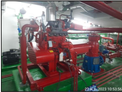
รูปที่ 52 ระบบน้ำสำรองเพื่อการดับเพลิง
