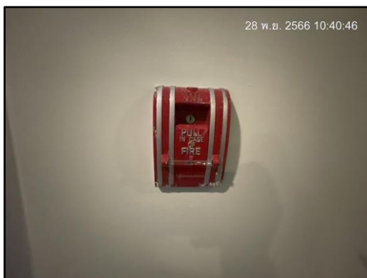
รูปที่ 48 อุปกรณ์เตือนภัยแบบใช้มือดึง
