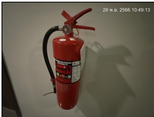
รูปที่ 47 ถังดับเพลิงแบบมือถือ
