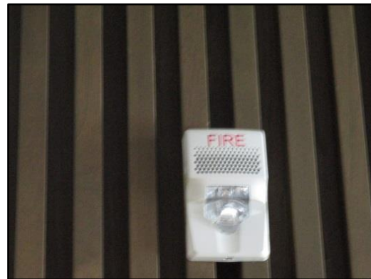
รูปที่ 49 อุปกรณ์เตือนภัยแบบใช้แสงและเสียง
