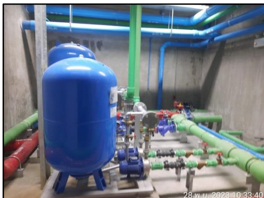
รูปที่ 19 ระบบเครื่องปั้มน้ำใช้ในโครงการ
