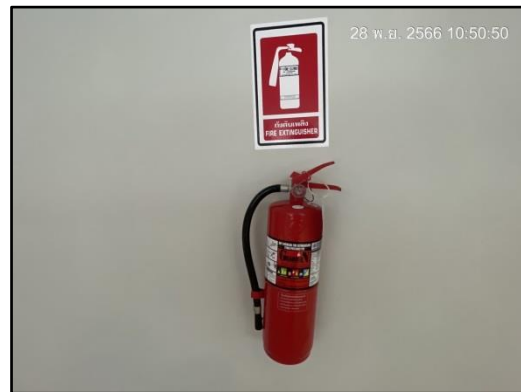
รูปที่ 47 ถังดับเพลิงแบบมือถือ
