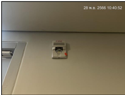
รูปที่ 49 อุปกรณ์เตือนภัยแบบใช้แสงและเสียง
